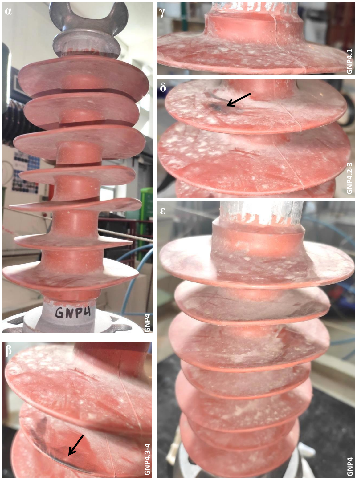
Εικόνα 4.20 Φωτογραφίες από τον οπτικό έλεγχο του μονωτήρα GNP4
