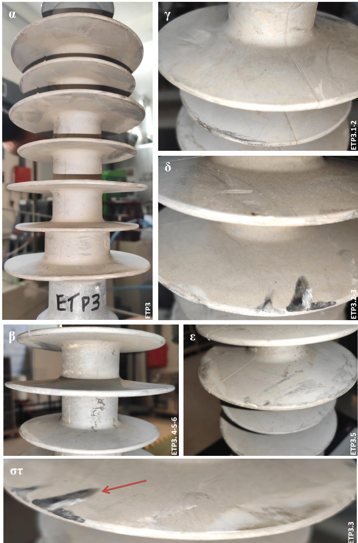
Εικόνα 4.16 Φωτογραφίες από τον οπτικό έλεγχο του μονωτήρα ETP3
