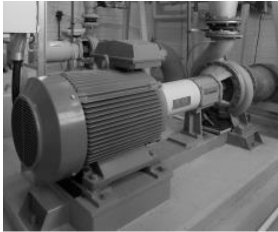
Εικόνα 3-2 Σύστημα φυγόκεντρης αντλίας-κινητήρα, [29]
