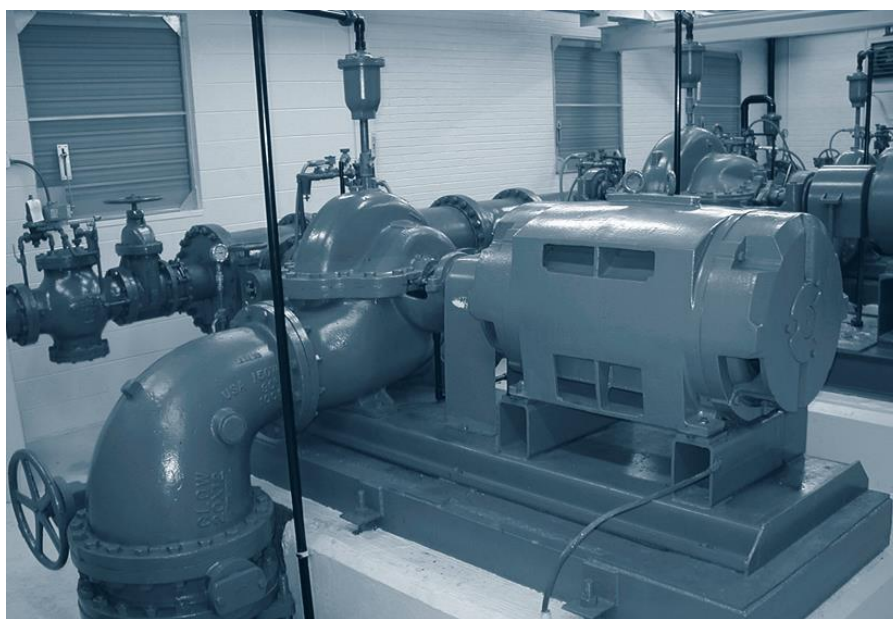
Εικόνα 3-1 Αντλία κινούμενη από ηλεκτρικό κινητήρα, [28]
