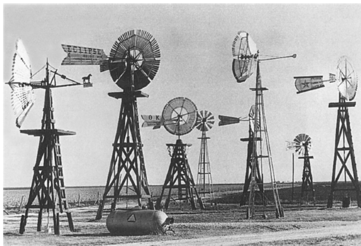
Σχήμα 1.2: Τυπικοί αμερικάνικοι ανεμόμυλοι (ανεμαντλίες) πολλαπλών πτερυγίων, που χρησιμοποιήθηκαν κατά κόρον για άντληση νερού σε αγροτικές περιοχές [4]
