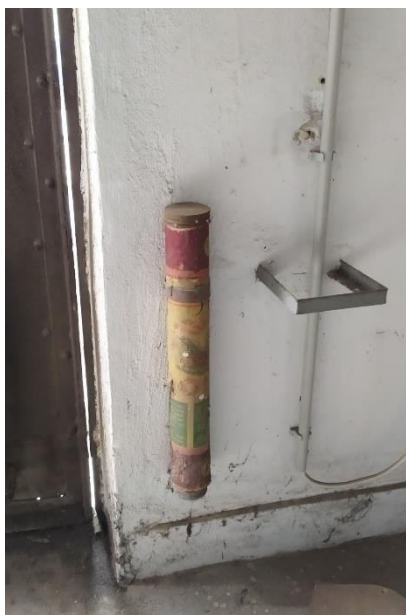
Εικόνα 29. Τύπος Πυροσβεστήρας στους πρώτους Υ/Σ Πόλεως, Πηγή: Προσωπικό Αρχείο
