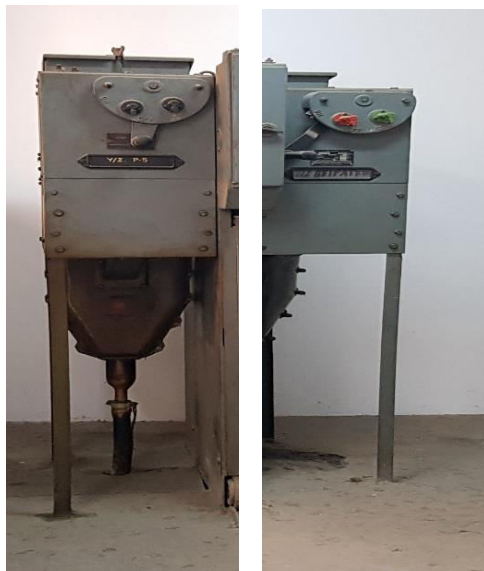
Εικόνα 36. Διακόπτες Ελαίου ( Οι Διακόπτες των δυο ακραίων μονάδων, προς τον Υ/Σ P-5 & προς τον Υ/Σ της Πειραικής, που αποτελούνται από τριπολικό διακόπτη μέσα σε λάδι και λειτουργούν χειροκίνητα), Πηγή: Προσωπικό Αρχείο
