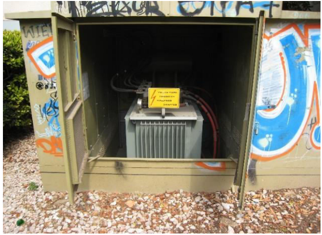
Εικόνα 6. Διαμέρισμα Μέσης Τάσης & Διαμέρισμα Μ/Σ σε Υ/Σ COMPACT, Πηγή: Προσωπικό Αρχείο
