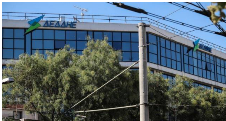
Εικόνα 1. Η Έδρα του ΔΕΔΔΗΕ στη συμβολή των οδών Περραιβού 20 & Καλλιρόης 5 στην Αθήνα
