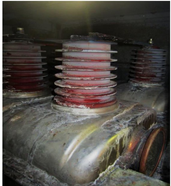
Εικόνα 93. Βραχυκύκλωμα στους Ζυγούς της Μέσης Τάσης, Πηγή: [14]
