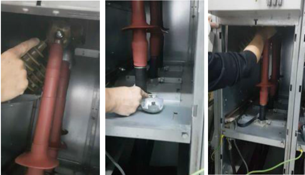
Εικόνα 130. Επανατοποθέτηση & σύσφιξη ειδικού προστατευτικού καλύματος στο ακροκιβώτιο της 3 ης φάσης του υπογείου καλωδίου Μ.Τ. στην Μονάδα Άφιξης του Πίνακα Μέσης Τάσης, Πηγή: Προσωπικό Αρχείο
