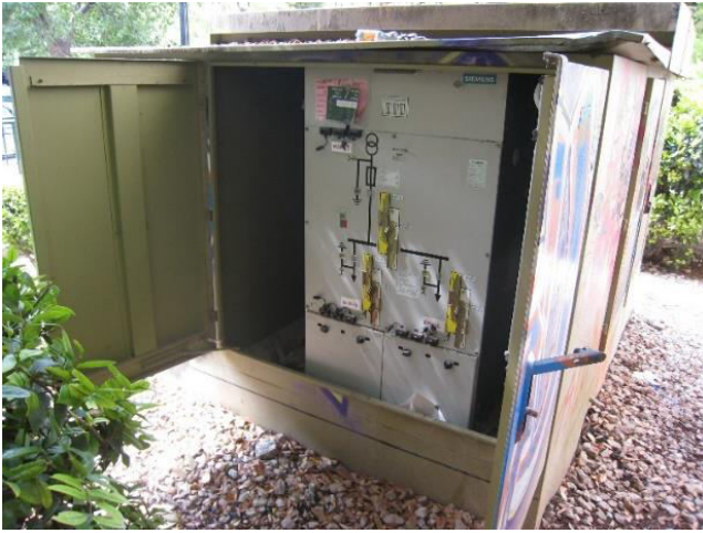
Εικόνα 6. Διαμέρισμα Μέσης Τάσης & Διαμέρισμα Μ/Σ σε Υ/Σ COMPACT, Πηγή: Προσωπικό Αρχείο
