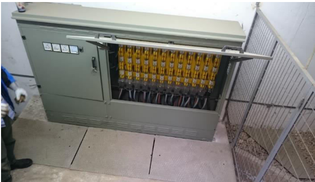
Εικόνα 12. Χώρος Πίνακα Χαμηλής Τάσης (Πίλαρ) & όδευση των υπογείων αναχωρήσεων Χαμηλής Τάσης του Υπόγειου Υ/Σ Πόλεως ΠΒ-85 προς τους καταναλωτές, Πηγή: Προσωπικό Αρχείο
