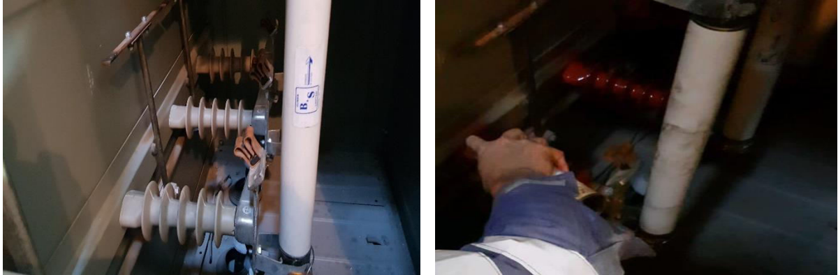
Εικόνα 115. Αντιμετώπιση της υγρασίας που εντοπίστηκε στους μονωτήρες στήριξης των κόκκινων καλωδίων Μέσης Τάσης στην Μονάδα Προστασίας του Μ/Σ Ισχύος του Πίνακα Μέσης Τάσης, με την εφαρμογή ειδικού μονωτικού βερνικιού (σπρέυ), Πηγή: Προσωπικό Αρχείο
