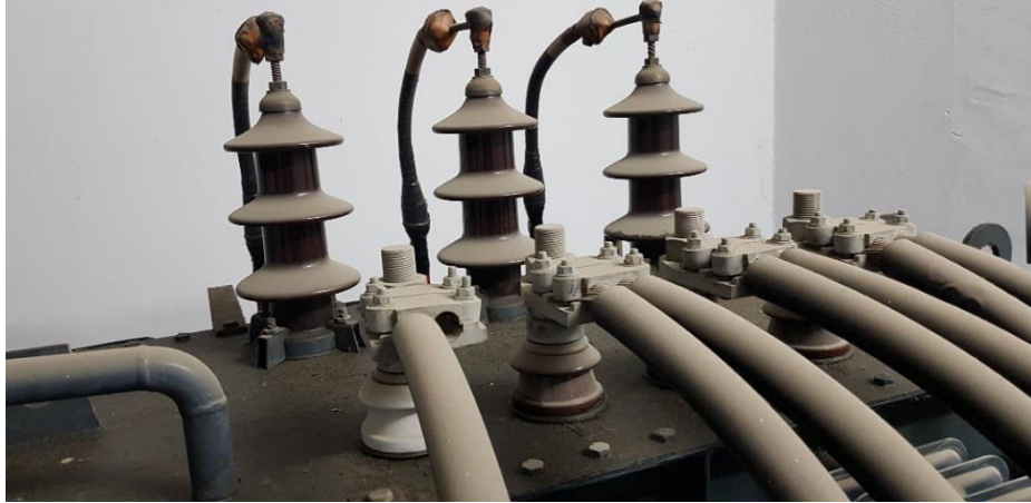
Εικόνα 42. Οι ακροδέκτες Χαμηλής Τάσης (μπροστά, με τους μικρούς μονωτηρες) & Μέσης Τάσης (στο βάθος με τους μεγάλους μονωτήρες), Πηγή: Προσωπικό Αρχείο
