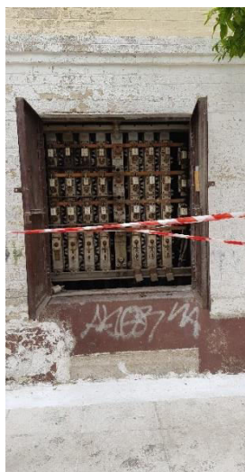
Εικόνα 30. Ο Πίνακας Χαμηλής Τάσης του Υ/Σ P-5 αποτελείται από 8 Αναχωρήσεις & η καρτέλα σήμανσης των οδών που εξυπηρετούν, Πηγή: Προσωπικό Αρχείο
