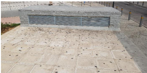
Εικόνα 68. Οι δύο Αεροθυρίδες (περσίδες) στο άνω μέρος του Υ/Σ εξασφαλίζουν τον φυσικό εξαερισμό του Υ/Σ ΠΚ-73, Πηγή: Προσωπικό Αρχείο
