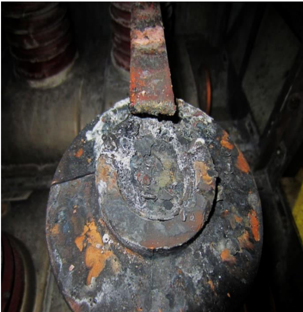
Εικόνα 93. Βραχυκύκλωμα στους Ζυγούς της Μέσης Τάσης, Πηγή: [14]
