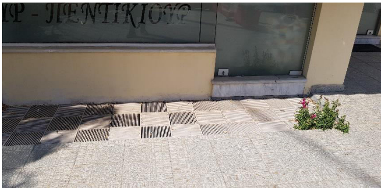
Εικόνα 104. Η Σχάρα εξαερισμού του Υπόγειου Υ/Σ Πόλεως ΝΔ-126, Πηγή: Προσωπικό Αρχείο
