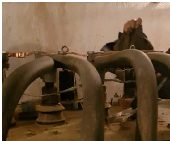
Εικόνα 119. Καθαρισμός του Μ/Σ Ισχύος του Υ/Σ ΝΔ-126 στο πλαίσιο της Προληπτικής Συντήρησης Πηγή: Προσωπικό Αρχείο
