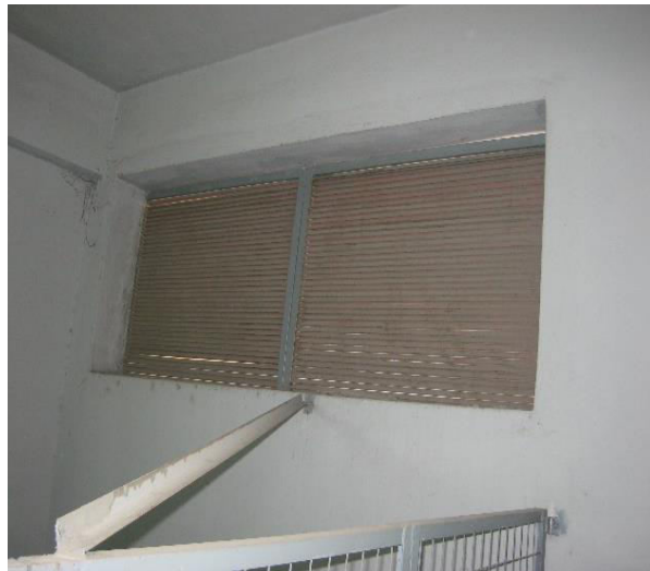
Εικόνα 8. Τυπική Είσοδος και Περίδες Αερισμού ενός Επίγειου Υ/Σ Πόλεως, Πηγή: Προσωπικό Αρχείο
