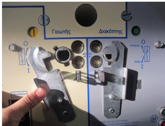
Εικόνα 52. Πρόσοψη Διακόπτη Φορτίου – Μικρό Διάγραμμα, Πηγή: Προσωπικό Αρχείο
