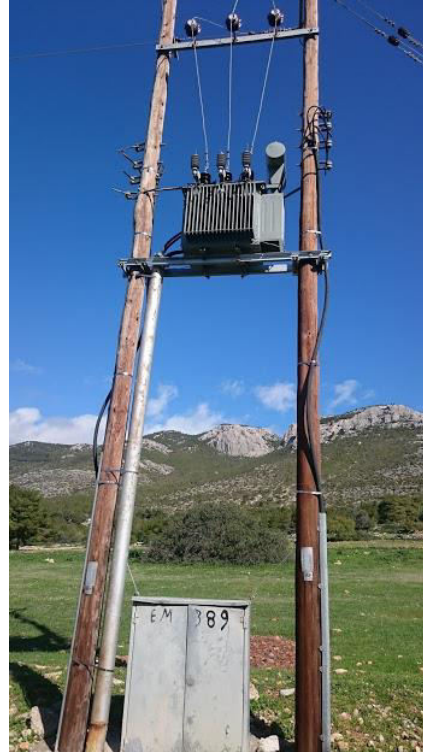
Εικόνα 3. Εναέριοι Υ/Σ Διανομής σετσιμέντινους & ξύλινους στύλους, Πηγή: Προσωπικό Αρχείο
