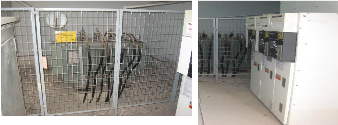
Εικόνα 9. Χώρος Μ/Σ & Πινάκα Μέσης Τάσης σε Επίγειο Υ/Σ Πόλεως, Πηγή: Προσωπικό Αρχείο
