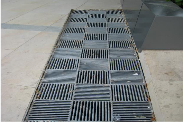
Εικόνα 13. Σχάρα Αερισμού και Περίδες Αερισμού ενός Υπόγειου Υ/Σ Διανομής Πόλεως, Πηγή: Προσωπικό Αρχείο
