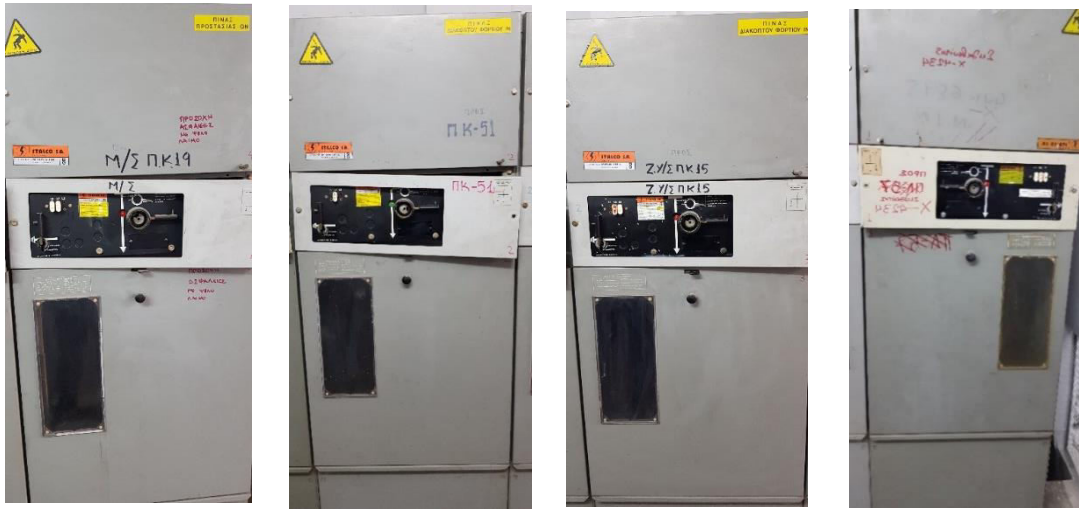
Εικόνα 39. Οι Επιμέρους μονάδες του Πίνακα Μέσης Τάσης του Υ/Σ Πόλεως ΠΚ-19, Πηγή: Προσωπικό Αρχείο
