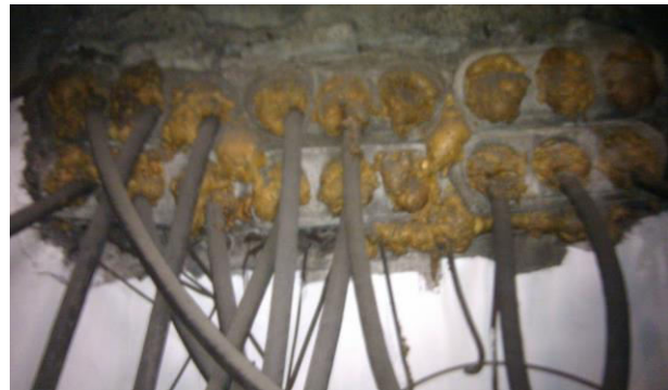
Εικόνα 12. Χώρος Πίνακα Χαμηλής Τάσης (Πίλαρ) & όδευση των υπογείων αναχωρήσεων Χαμηλής Τάσης του Υπόγειου Υ/Σ Πόλεως ΠΒ-85 προς τους καταναλωτές, Πηγή: Προσωπικό Αρχείο
