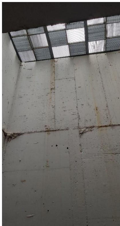
Εικόνα 83. Σχάρα Αερισμού του Υπόγειου Υ/Σ Πόλεως ΠΚ-92, Πηγή: Προσωπικό Αρχείο
