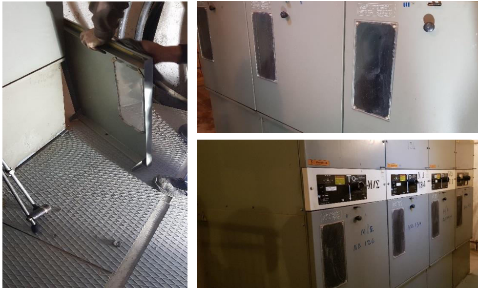
Εικόνα 118. Επανατοποθέτηση των μεταλλικών θυρών στις επιμέρους Μονάδες του Πίνακα Μέσης Τάσης, μετά την ολοκλήρωση της Συντήρησης, Πηγή: Προσωπικό Αρχείο
