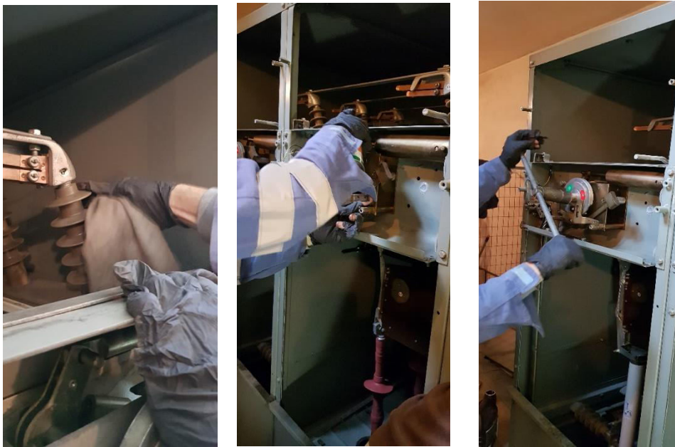
Εικόνα 111. Εργασίες Συντήρησης Πίνακα Μέσης Τάσης σε πλήρη εξέλιξη
