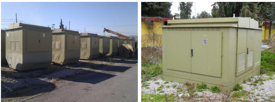
Εικόνα 5. Υ/Σ COMPACT, Πηγή: Προσωπικό Αρχείο
