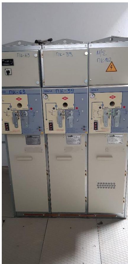
Εικόνα 77. Ο Πίνακας Μέσης Τάσης του Υ/Σ ΠΚ-92 με δύο πεδία άφιξης και ένα πεδίο προστασίας του Μ/Σ, φέρει ισάριθμους Διακόπτες Φορτίου με μόνωση SF6 , Πηγή: Προσωπικό Αρχείο
