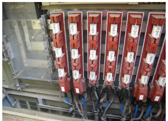
Εικόνα 7. Διαμέρισμα Χαμηλής Τάσης σε Υ/Σ COMPACT, Πηγή: Προσωπικό Αρχείο
