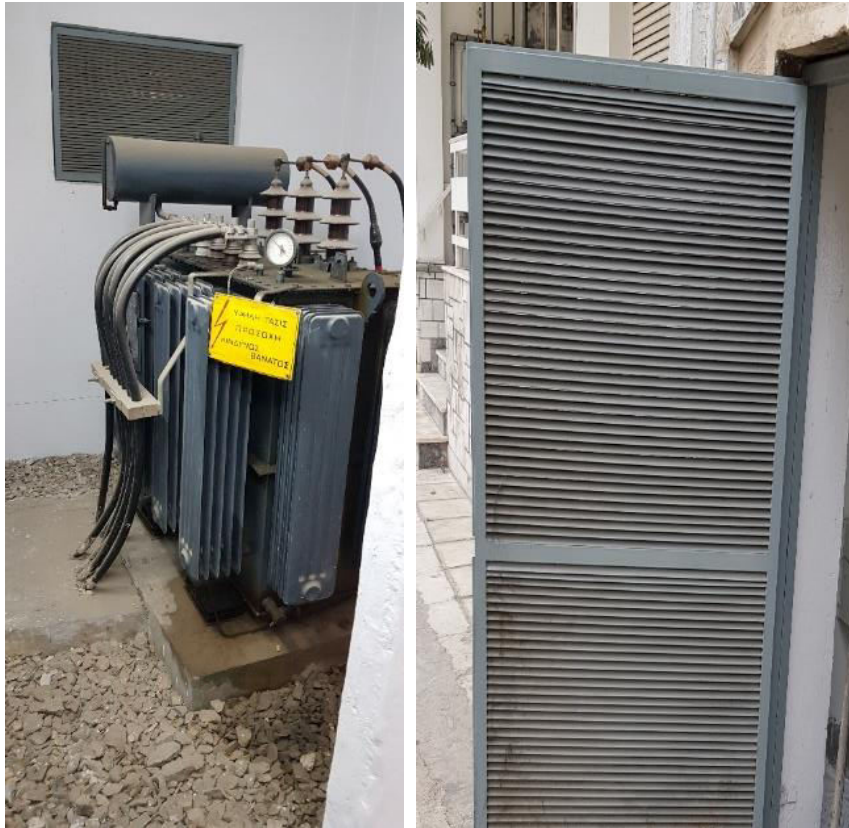
Εικόνα 45. Ο φυσικός εξαερισμός του Υ/Σ επιτυγχάνεται μέσω των αεροθυρίδων (περσίδων) που υπάρχουν στο διαμέρισμα του Μ/Σ και της πόρτας της εισόδου του Υ/Σ, Πηγή: Προσωπικό Αρχείο
