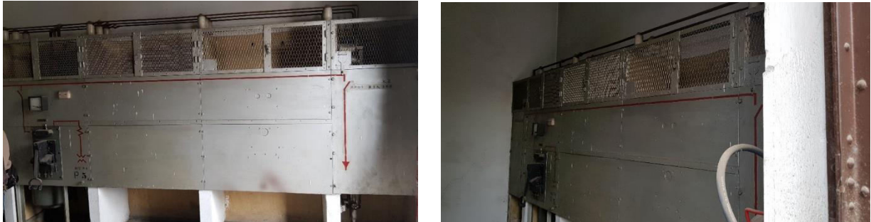
Εικόνα 20. Οι πρώτοι Πίνακες Μέσης Τάσης αποτελούσαν ιδιοκατασκευές, Πηγή: Προσωπικό Αρχείο
