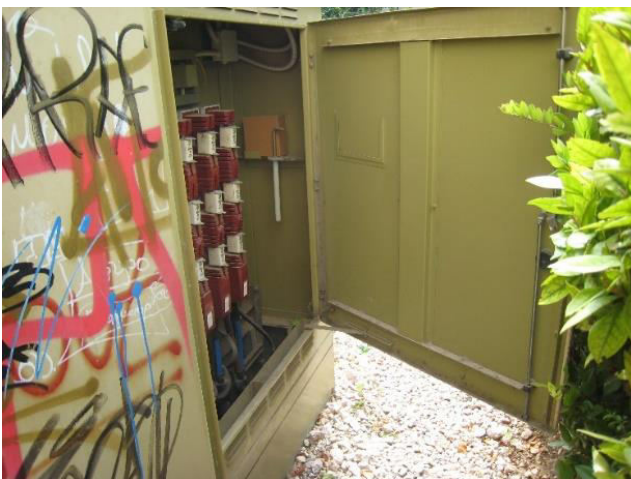
Εικόνα 7. Διαμέρισμα Χαμηλής Τάσης σε Υ/Σ COMPACT, Πηγή: Προσωπικό Αρχείο
