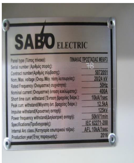
Εικόνα 50. Χαρακτηριστικά Πινάκων Μέσης Τάσης, Πηγή: Προσωπικό Αρχείο
