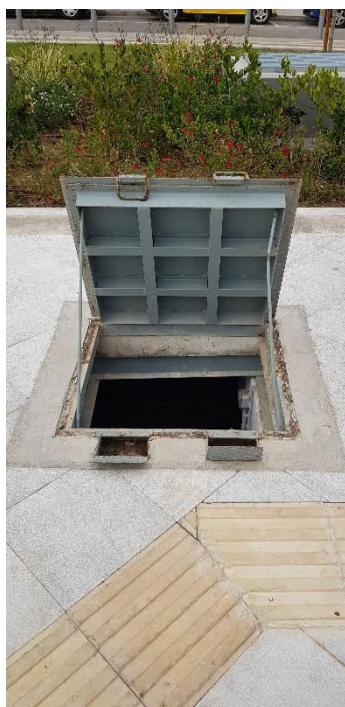
Εικόνα 74. Καταπακτή – Είσοδος Υ/Σ , Πηγή: Προσωπικό Αρχείο
