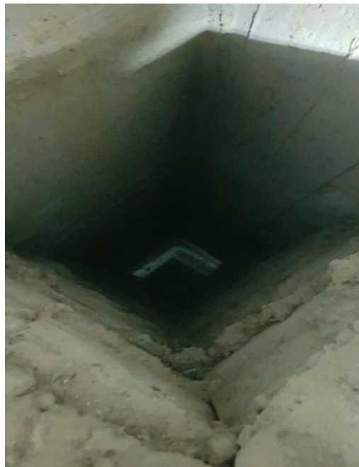
Εικόνα 67. Η Τρύπα Εκτόνωσης των υπογείων υδάτων της στεγανολεκάνης Πηγή: Προσωπικό Αρχείο
