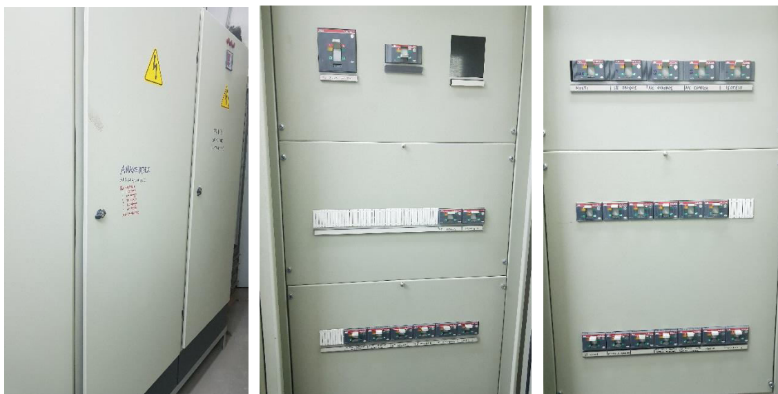
Εικόνα 143. Τα Πεδία Αναχωρήσεων προς τα φορτία του ΓΑΛΑΞΙΑ (χωρισμένα ανά τμήμα), Πηγή: Προσωπικό Αρχείο
