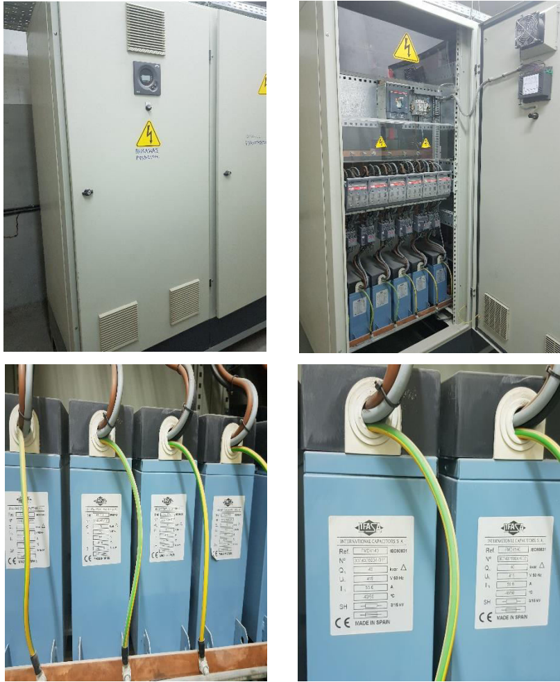
Εικόνα 144. Το Πεδίο Αντιστάθμισης περιλαμβάνει πέντε πυκνωτές Ονομαστικού Χωρητικού Φορτίου, Q_N = 40 \text{ kvar} , έκαστος, Πηγή: Προσωπικό Αρχείο
