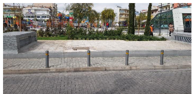
Εικόνα 68. Οι δύο Αεροθυρίδες (περσίδες) στο άνω μέρος του Υ/Σ εξασφαλίζουν τον φυσικό εξαερισμό του Υ/Σ ΠΚ-73, Πηγή: Προσωπικό Αρχείο
