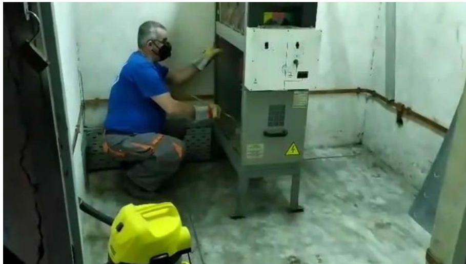
Εικόνα 137. Καθαρισμός του Πίνακα Μ.Τ. του ΓΑΛΑΞΙΑ στο πλαίσιο Προληπτικής Συντήρησης της εγκατάστασης του Καταναλωτή Μ.Τ., Πηγή: Προσωπικό Αρχείο
