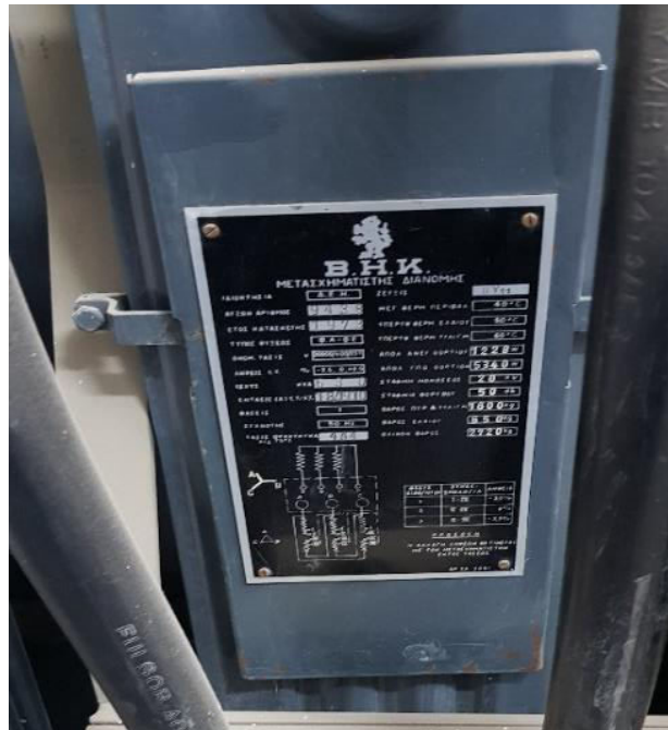
Εικόνα 40. Η Πινακίδα του Μ/Σ του Υ/Σ Πόλεως ΠΚ-19, Πηγή: Προσωπικό Αρχείο
