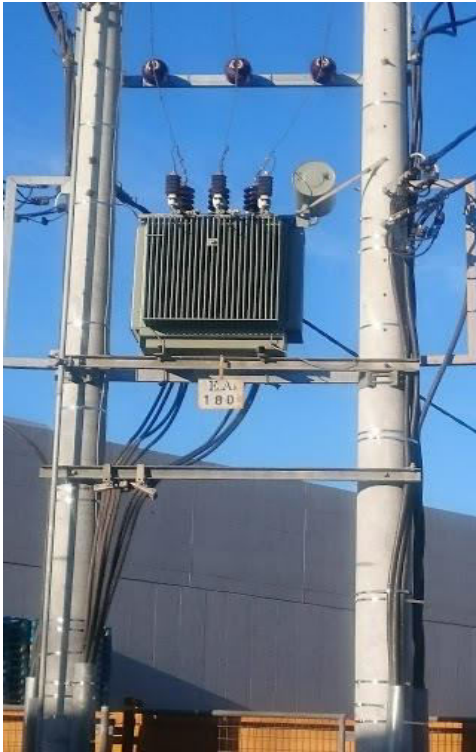
Εικόνα 3. Εναέριοι Υ/Σ Διανομής σετσιμέντινους & ξύλινους στύλους, Πηγή: Προσωπικό Αρχείο
