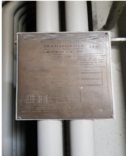
Εικόνα 25. Η Πινακίδα του Μ/Σ, Πηγή: Προσωπικό Αρχείο
