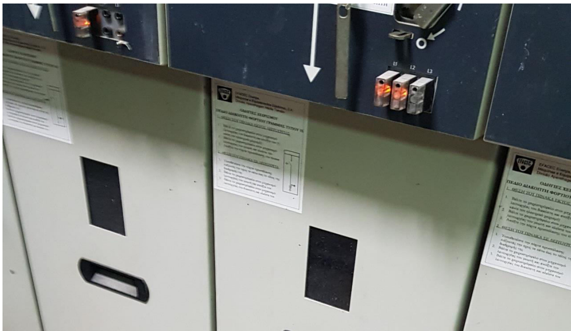
Εικόνα 62. Πρόσοψη Διακόπτη Φορτίου – Μιμικό Διάγραμμα, Πηγή: Προσωπικό Αρχείο
