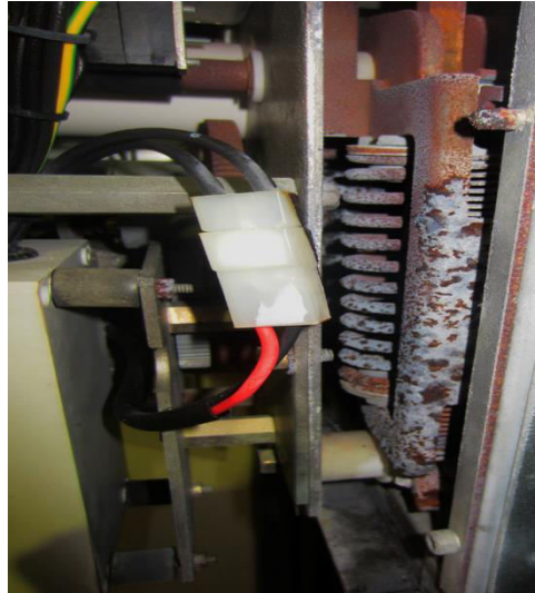
Εικόνα 91. Σκουριές στους Μηχανισμούς των Πινάκων ΜΤ, Πηγή: [14]
