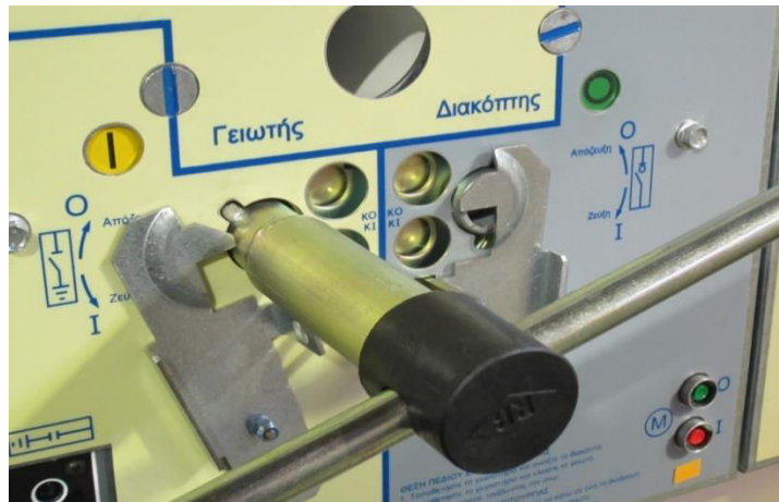
Εικόνα 55. Τοποθέτηση Χειριστηρίου – Μανέλας, Πηγή: Προσωπικό Αρχείο
