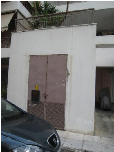
Εικόνα 8. Τυπική Είσοδος και Περίδες Αερισμού ενός Επίγειου Υ/Σ Πόλεως, Πηγή: Προσωπικό Αρχείο
