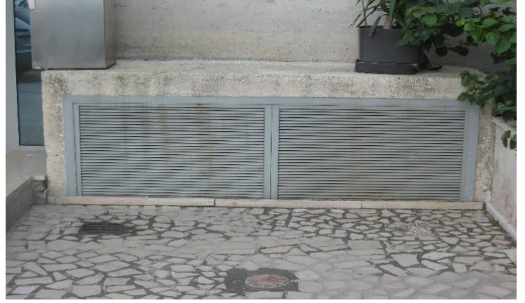
Εικόνα 13. Σχάρα Αερισμού και Περίδες Αερισμού ενός Υπόγειου Υ/Σ Διανομής Πόλεως, Πηγή: Προσωπικό Αρχείο
