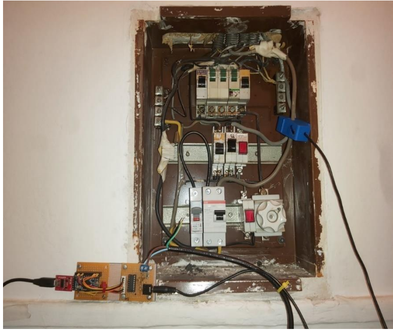
Σχήμα 61-Εγκατάσταση Μετρητή(1)
