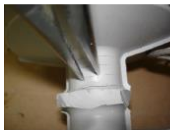
Εικόνα 2.4. Τράβηγμα τετραγώνων με την βοήθεια πένσας [25]
