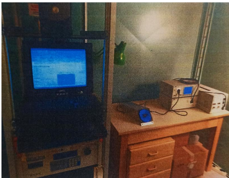
Εικόνα 53: Εγκατάσταση για δοκιμή διακυμάνσεων της τάσης
