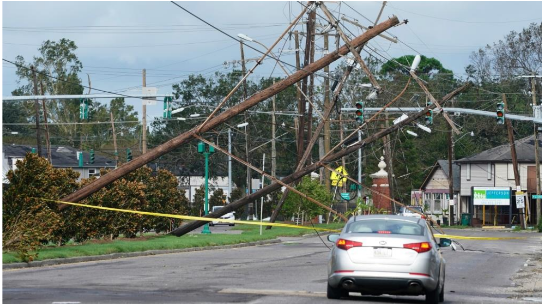
Εικόνα 4. Πεσμένοι πυλώνες και γραμμές μεταφοράς μετά το πέρασμα του τυφώνα Ida στη Louisiana το 2021 [11]
