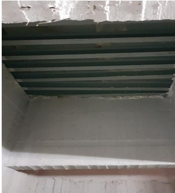
Εικόνα 97 Καταπακτή εισόδου – εξόδου μηχανημάτων με κοιλοδοκούς
