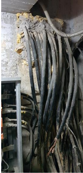
Εικόνα 102 Όδευση καλωδίων Χαμηλής Τάσης από τον χώρο του Υ/Σ προς τους καταναλωτές
