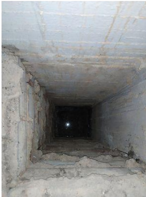
Εικόνα 103 Η 'τρύπα' Εκτόνωσης των υπογείων υδάτων της στεγανολεκάνης
