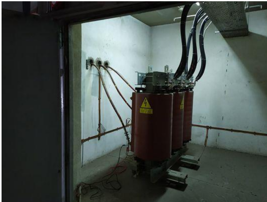
Εικόνα 121 Χώρος Μ/Σ Ιδιώτη
