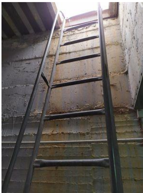
Εικόνα 96 Είσοδος του Υπόγειου Υ/Σ Πόλεως ΠΚ-73 στον Κορυδαλλό
