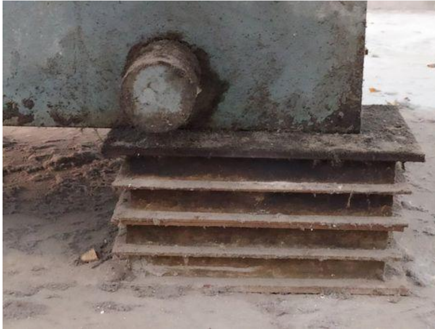
Εικόνα 80 Τιμμέντινη βάση & ειδικά πέλματα πάνω στα οποία τοποθετείται ο Μ/Σ
