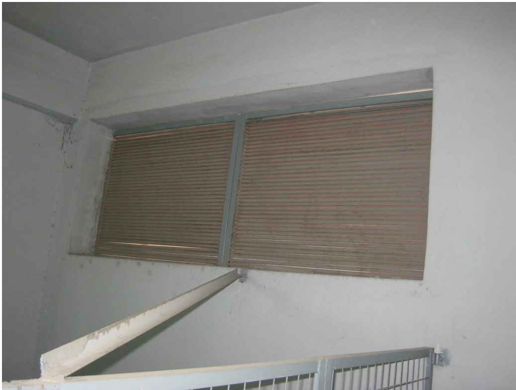
Εικόνα 25 Θυρίδες εξαερισμού σε Υ/Σ Πόλεως
