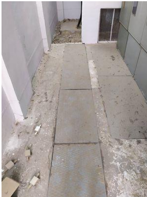
Εικόνα 92 Ειδικό κανάλι για όδευση των καλωδίων
