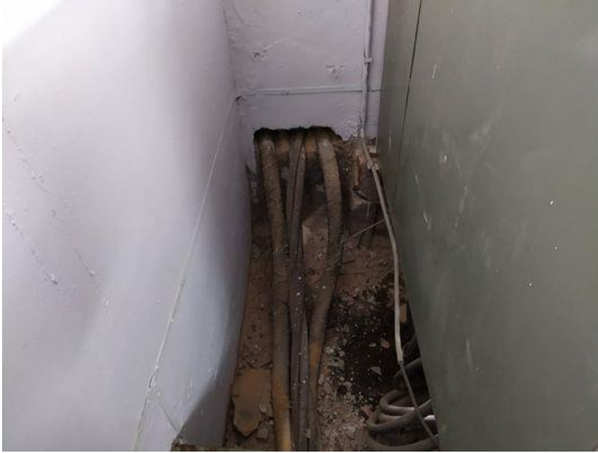
Εικόνα 93 Ειδικό κανάλι για όδευση των καλωδίων
