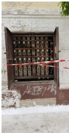
Εικόνα 73 Ο Πίνακας Χαμηλής Τάσης του Υ/Σ P-5 8 Αναχωρήσεων & καρτέλα σήμανσης των οδών που εξυπηρετούν.
