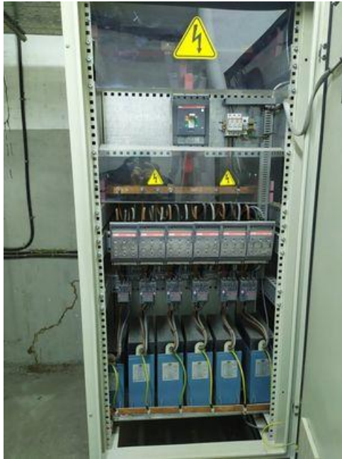
Εικόνα 128 Πυκνωτές Ιδιώτη για ρύθμιση συνημίτονου
