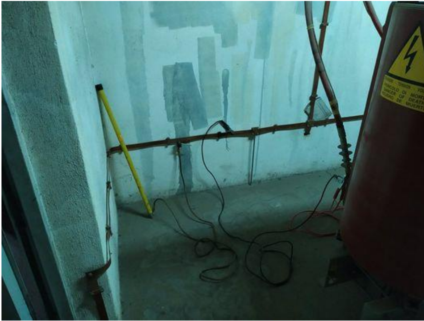
Εικόνα 122 Περιμετρική Γείωση
