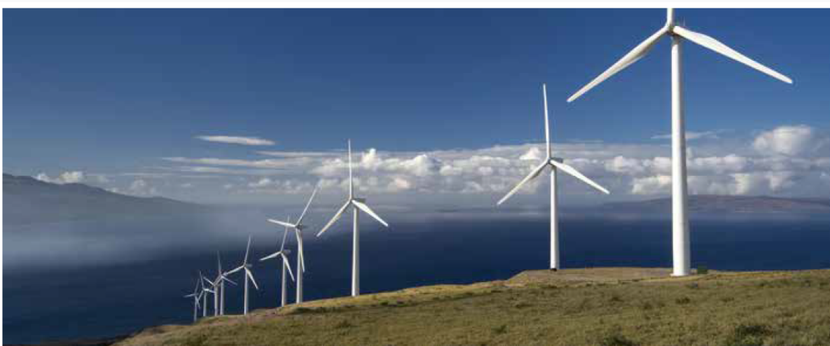
Εικόνα 3-6: Αιολικός σταθμός παραγωγής ενέργειας στο Μάουι της Χαβάης
