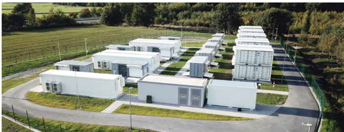
Εικόνα 3-7: Μπαταρίες από την NGK στο Varel (Γερμανία), παρόμοιες με αυτές στην περιοχή της Καμπανίας
