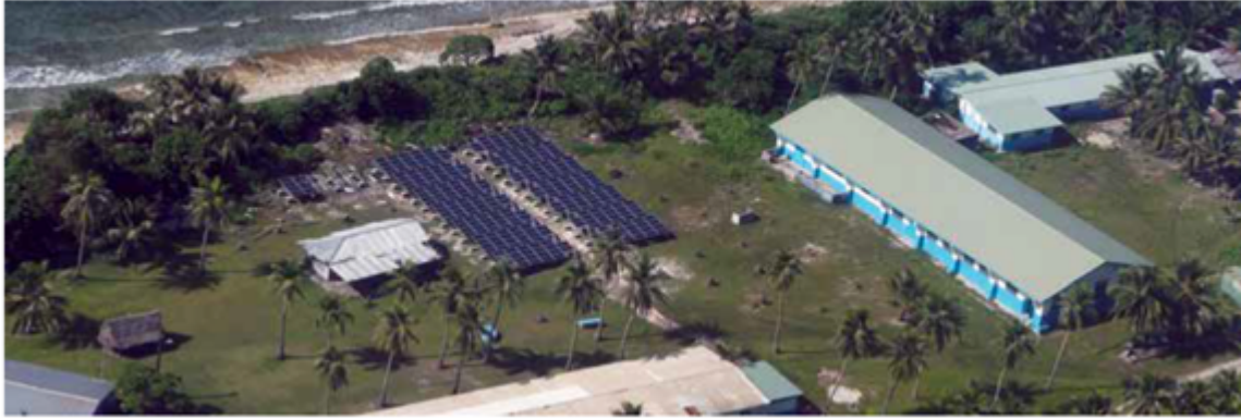
Εικόνα 3-10: Ηλιακό μίνι-δίκτυο 60 kW στο γυμνάσιο Ulithi, Πολιτεία Yap
