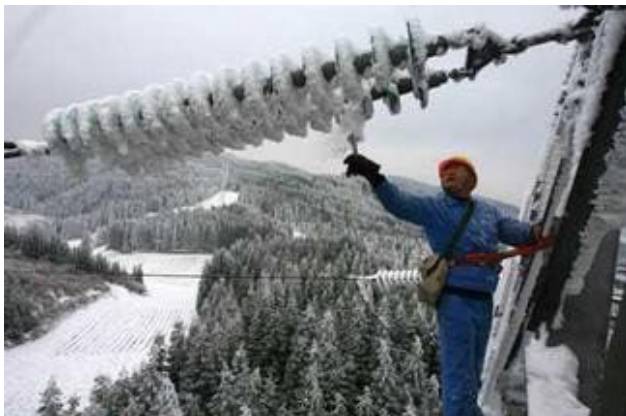
Σχήμα 1-18 : Πάγος σε Μονωτήρα [23]
