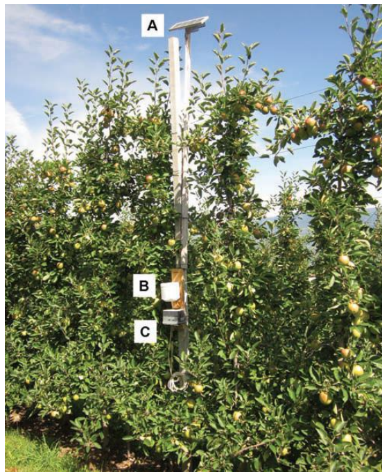
Εικόνα 47. Η μονάδα εγκατεστημένη ένα οπωρώνα μηλιάς. (A) Φωτοβολταϊκό πάνελ. (B) Πλακέτα μικροελεγκτή και (C) μπαταρία [40].
