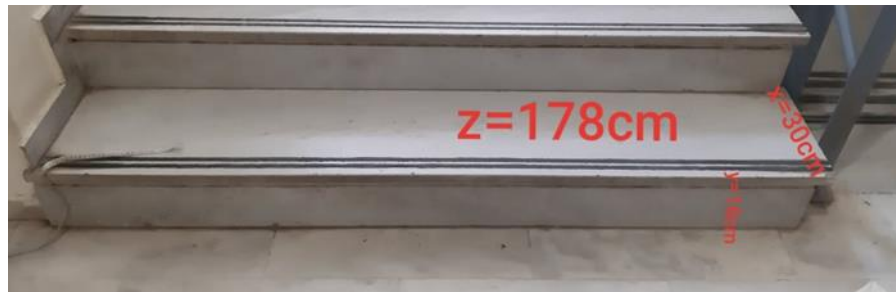
Εικόνα 6.48 Διαστάσεις ενός σκαλοπατιού στις σκάλες της σχολής
