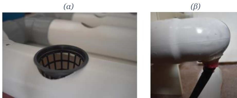
Σχήμα 66: Τοποθέτηση net pots (α) και μέσου αποστράγγισης (β).
