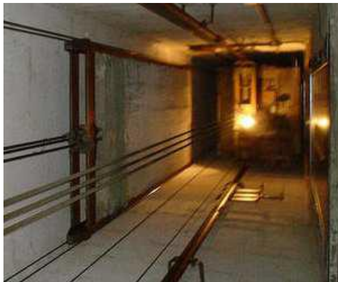
Εικόνα 11: Άποψη φρεατίου ανελκυστήρα τριβής χωρίς μηχανοστάσιο
