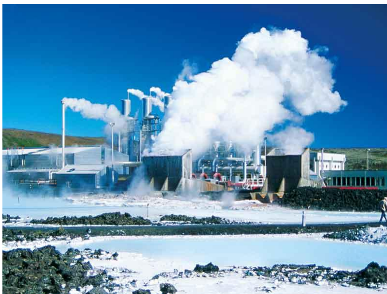
Εικόνα 1.6 Εργοστάσιο που εκμεταλλεύεται την γεωθερμική ενέργεια
