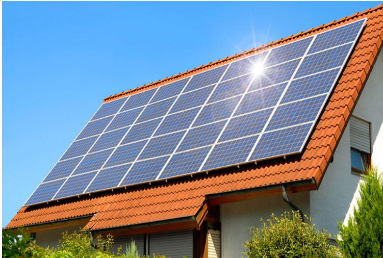
Εικόνα 1.3 Εγκατάσταση φωτοβολταϊκού συστήματος σε οικία
