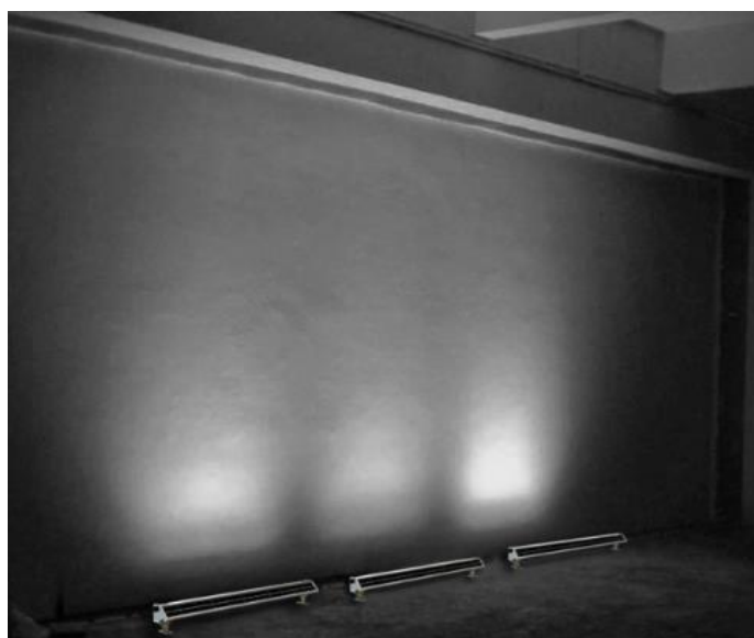
Εικόνα 2.16: Φωτισμός wall washing[7].
