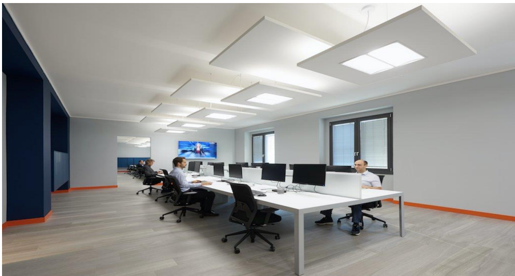
Εικόνα 2.10: Έμμεσος/άμεσος τοπικός φωτισμός[7].
