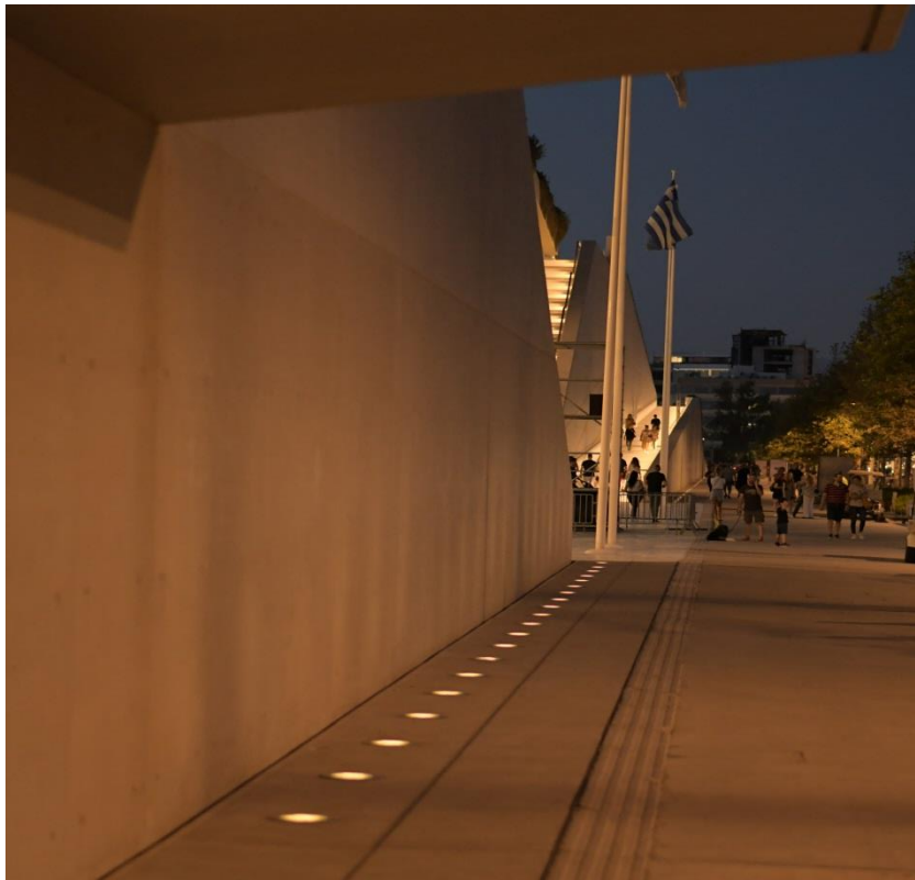
Εικόνα 4.15: Φωτιστικά uplight δαπέδου [Ίδια Επεξεργασία].
