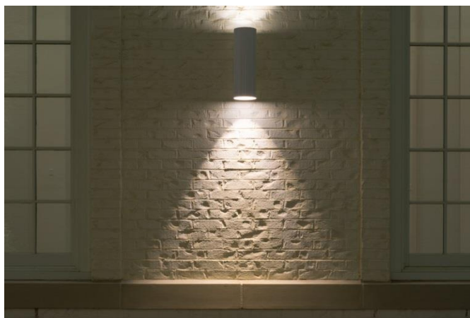
Εικόνα 2.15: Φωτισμός grazing[7].
