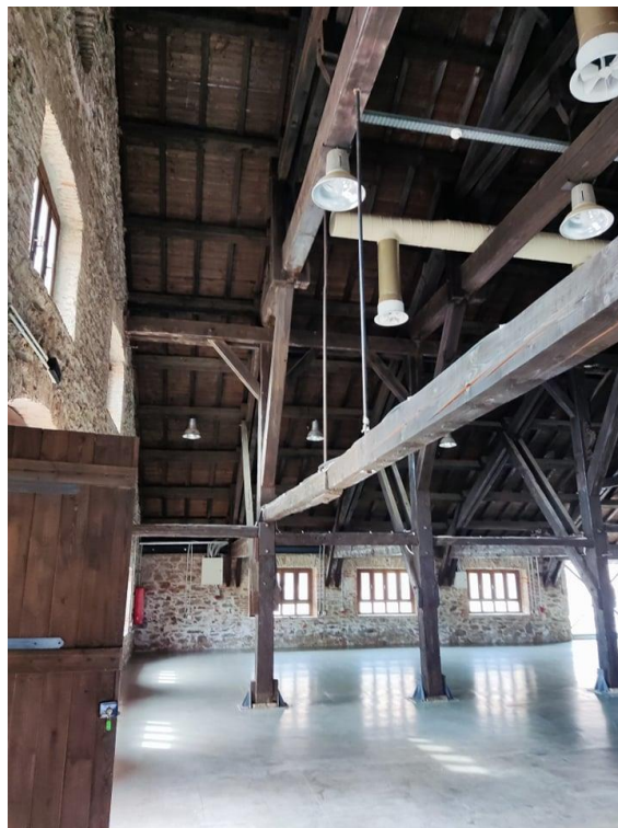
Εικόνα 5.9: Εσωτερική επισκόπηση πολυχώρου, «Κεντρική Σάλα» [Ιδία Επεξεργασία].
