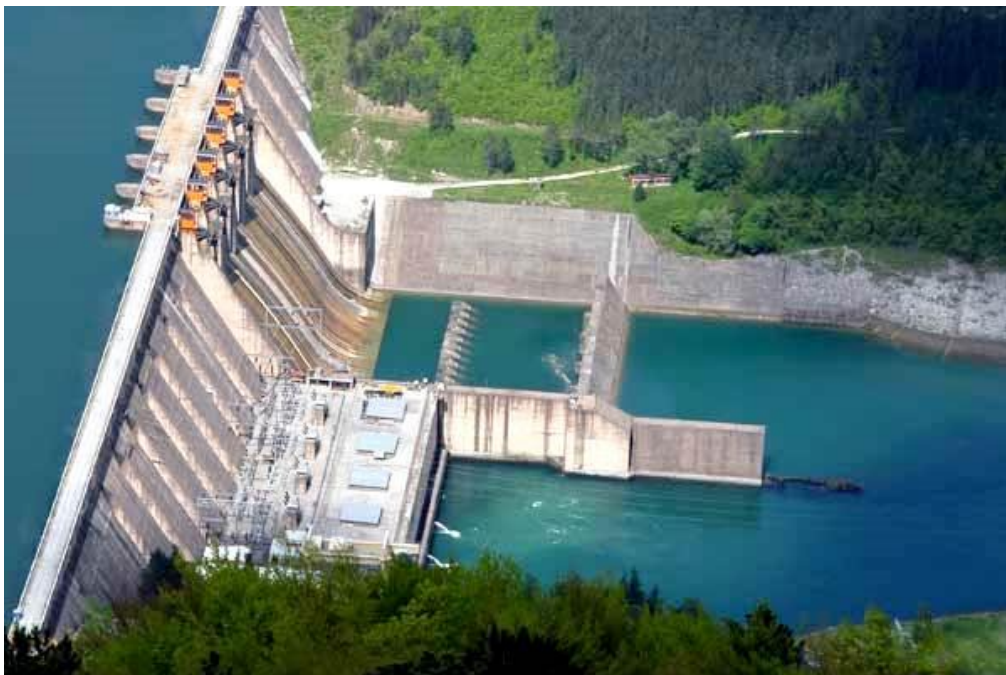
Εικόνα 8: Υδροηλεκτρικός σταθμός Βελβεντού [25].
