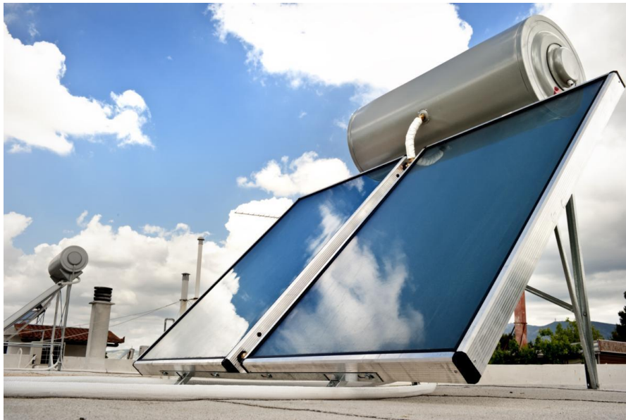
Εικόνα 12: Ηλιακός θερμοσίφοντας: Σύστημα χαμηλών θερμοκρασιών [83].
