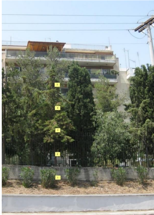
Φωτογραφία 6.1: Τα σημεία μέτρησης της γραμμής μέσης τάσης 20kV, παράλληλης της οδού Ηρώων Πολυτεχνείου, προς το εσωτερικό της Πολυτεχνειούπολης εντός της Πολυτεχνειούπολης
