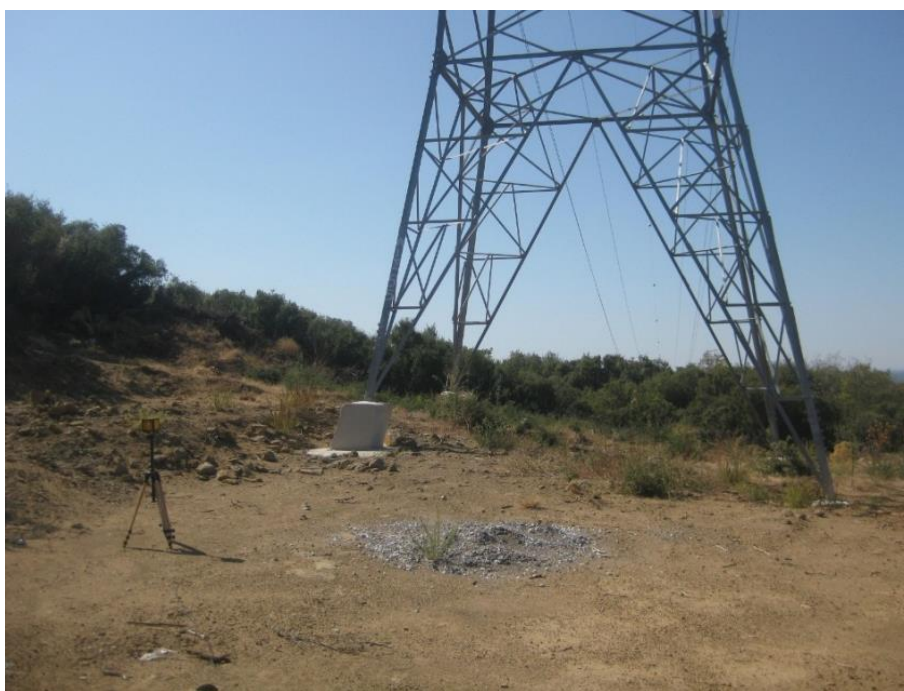
Φωτογραφία 6.2: Μέτρηση ηλεκτρικού πεδίου πλησίον του πυλώνα
