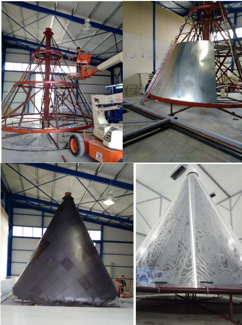
Σχήμα 3.6.14: Κωνική κατασκευή. Φαίνεται ο σκελετός, τα μαγνητικά φύλλα και η υδρόφιλη μεμβράνη
