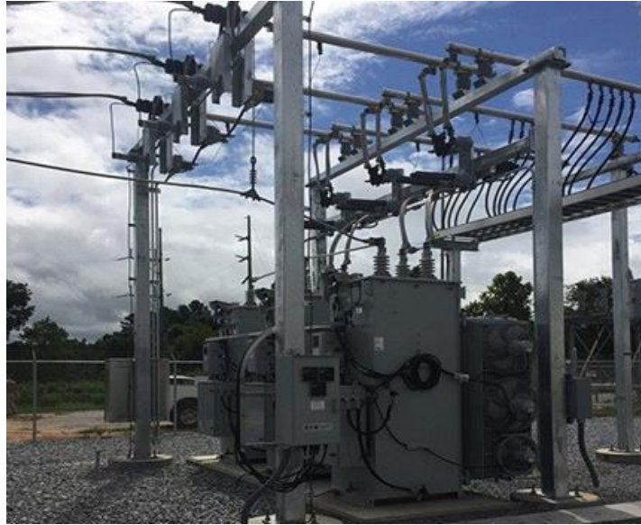
Σχήμα 2.3: Τμήμα Υποσταθμού Υποβιβασμού Τάσης 150/33kV
