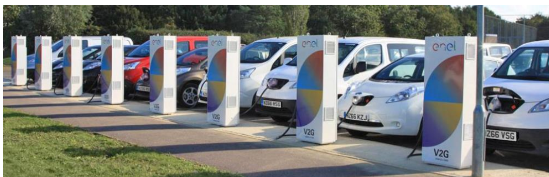
Εικόνα 16: Φόρτιση στον χώρο εργασίας.
