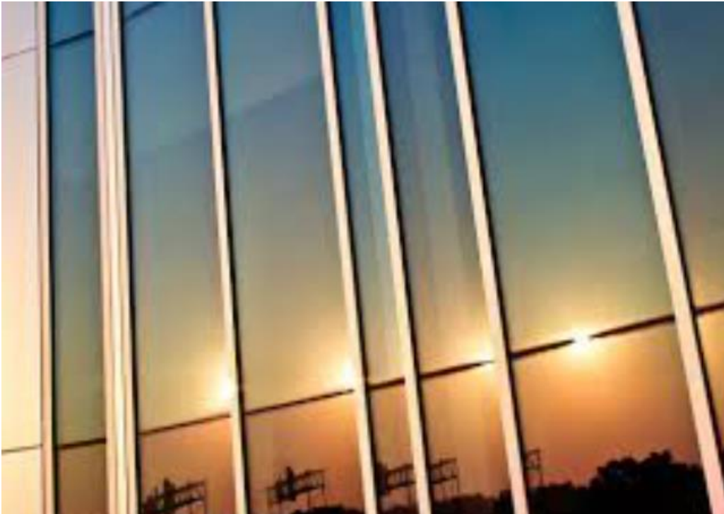
Σχήμα 2-17: Εφαρμογή τεχνολογίας πολυμερών φωτοβολταϊκών στοιχείων σε πρόσοψη κτηρίου στην Καλιφόρνια των ΗΠΑ [9].
