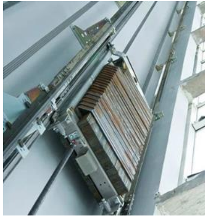
Σχήμα 3.3: Πραγματικό αντίβαρο
