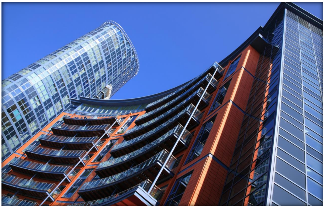
Εικόνα 3.2: Φωτοβολταϊκοί ναλοπίνακες με ημιδιαφάνεια τοποθετημένοι σε ένα κτίριο που λειτουργεί ως εκπαιδευτικός χώρος [25]
