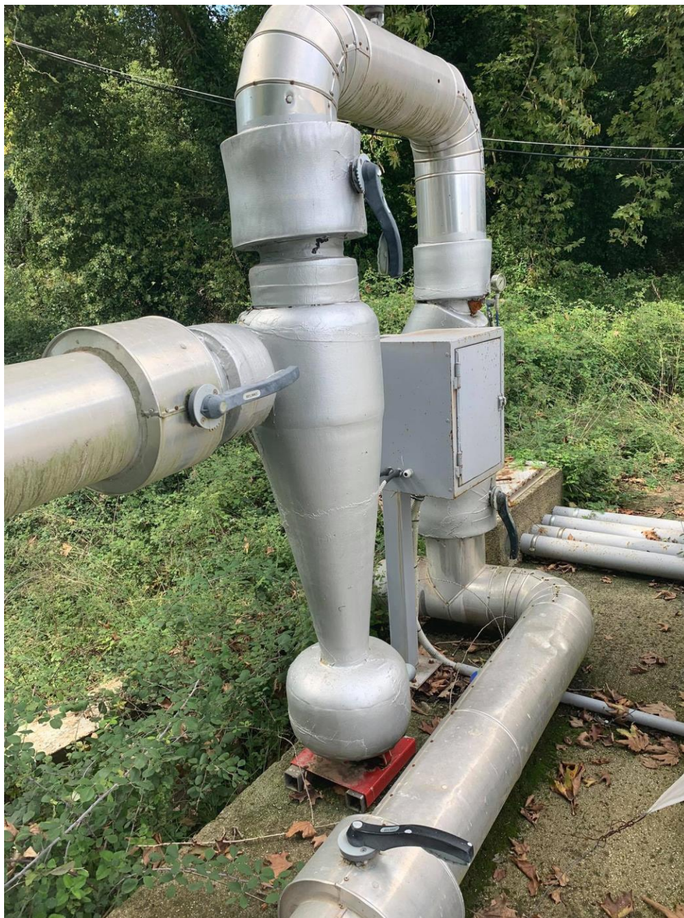
Εικόνα 17: Σύστημα φίλτρανσης τύπου υδροκυκλώνα
