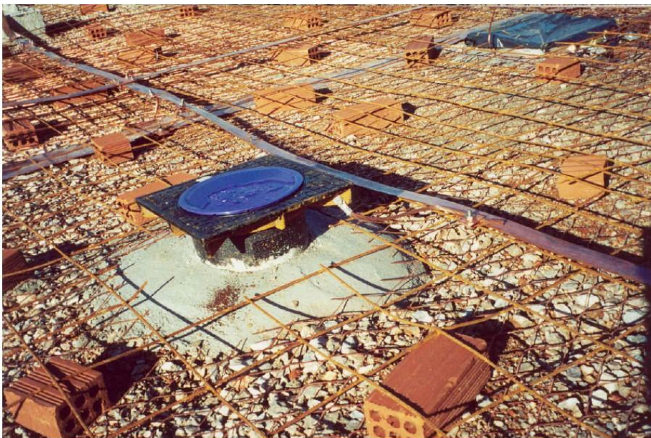
Εικόνα 2.6: Κατασκευή πλέγματος γείωσης υποσταθμού υψηλής τάσης [42].
