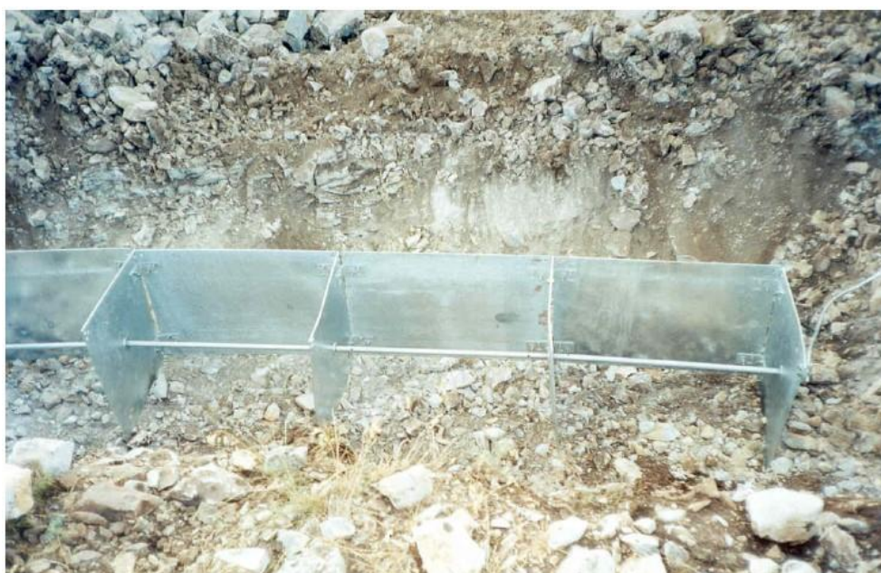
Εικόνα 2.12: Γειωτές πλάκας σε κάθετη συνδεσμολογία [42].
