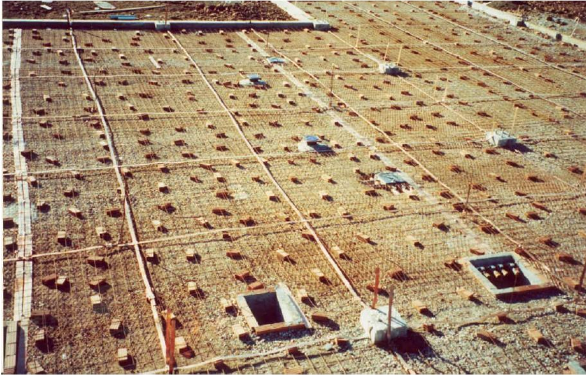
Εικόνα 2.7: Κατασκευή πλέγματος γείωσης υποσταθμού υψηλής τάσης (συνολική έκταση) [42].
