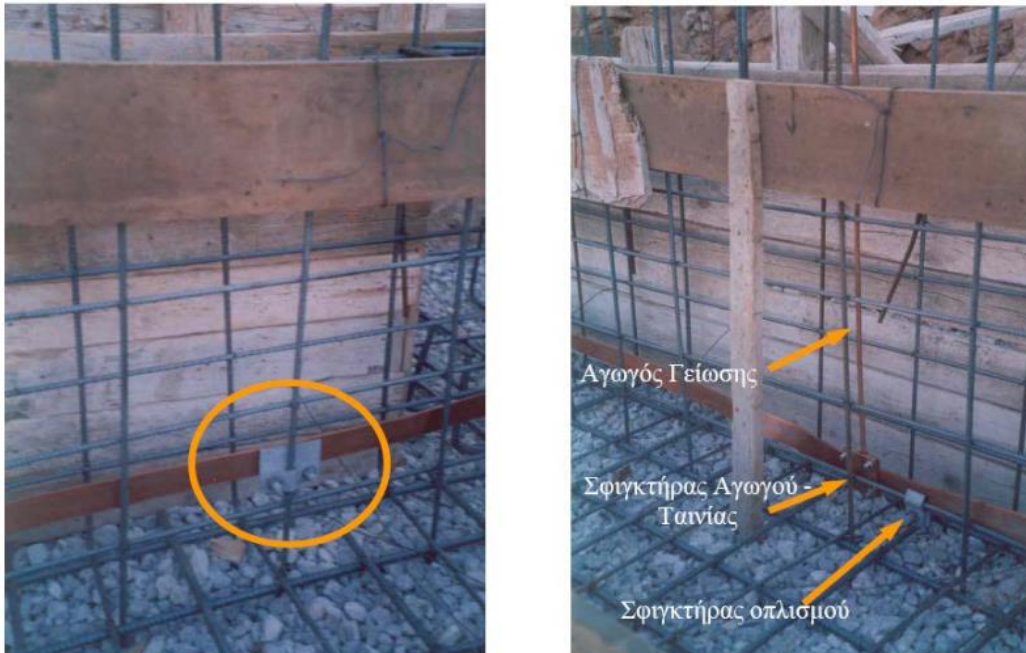
Σχήμα 4.3 Κατασκευαστικές λεπτομέρειες θεμελιακής γείωσης[8]
