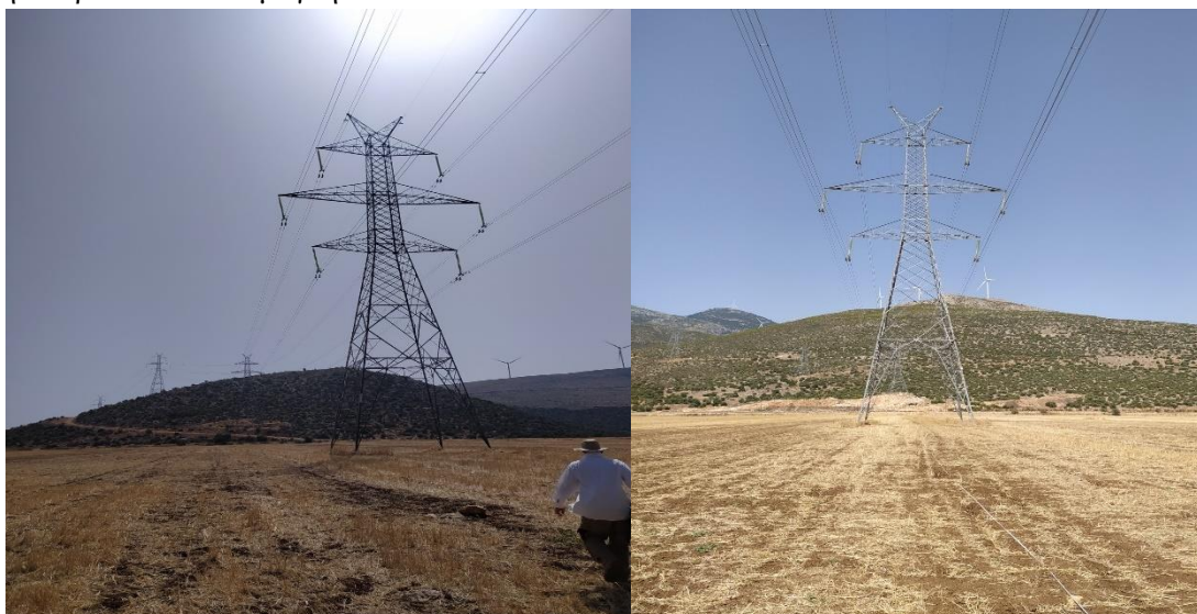
Εικόνα 6.22: Μέτρηση ηλεκτρικού πεδίου κατά μήκος του άξονα της γραμμής μεταφοράς.
