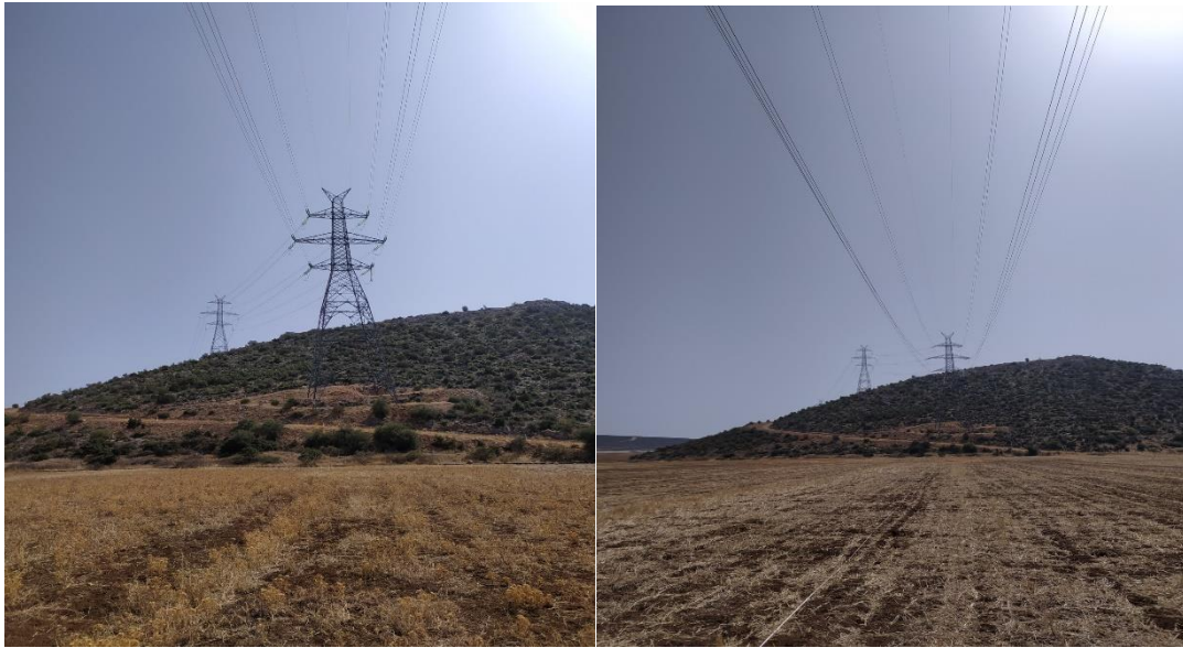
Εικόνα 6.23: Μέτρηση ηλεκτρικού και μαγνητικού πεδίου σε άξονα εγκάρσιο προς τη γραμμή..
