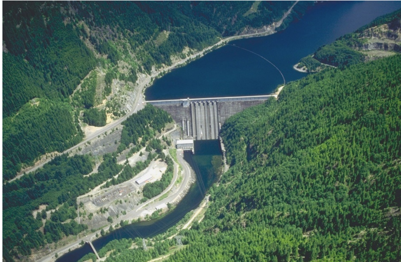
Εικόνα 15: Υδροηλεκτρικό φράγμα του Ντιτρόιτ [29]
