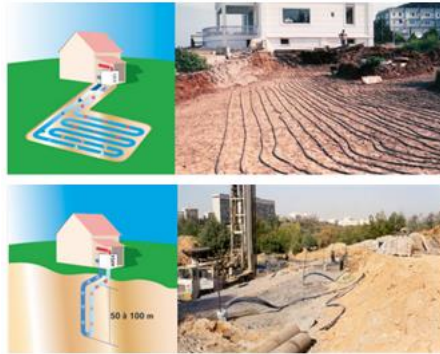
Εικόνα 10 - Γεωεναλλάκτες θερμότητας (Μπένου, 2009)
