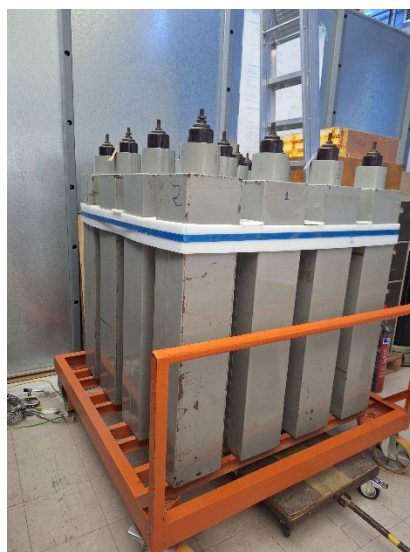
Εικόνα 5.4.3 Βάση κατασκευασμένη με τοποθετημένους τους πυκνωτές
