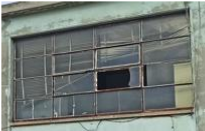
Εικόνα 17: Μορφή των υαλοστασίων του κτιρίου “Ε”
