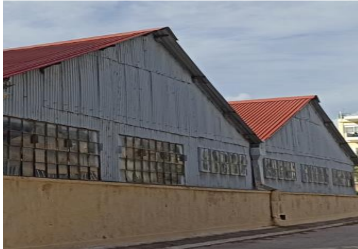
Εικόνα 13: Πλάγια δεξιά όψη του κτιρίου “Δ”
