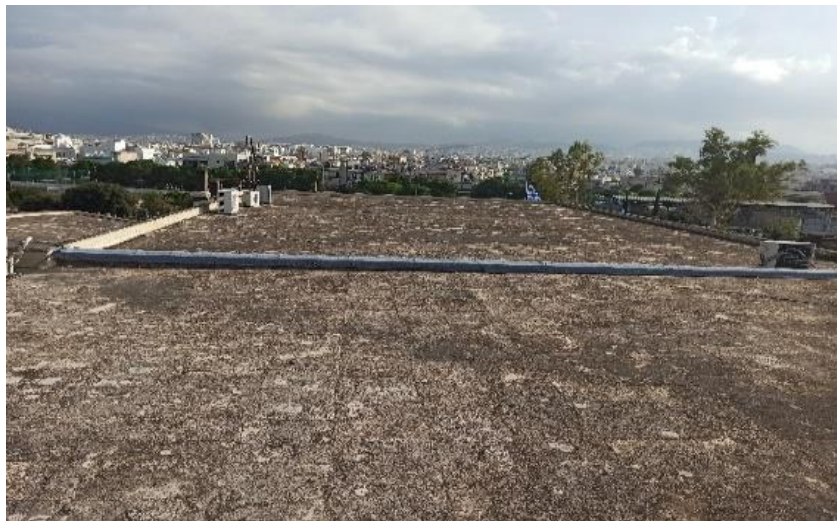
Εικόνα 6: Οροφή του κτιρίου “Α” από οπλισμένο σκυρόδεμα
