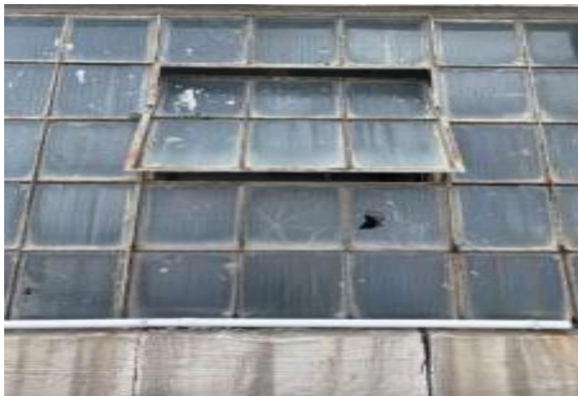
Εικόνα 9: Μορφή των υαλοστασίων του κτιρίου “Β”
