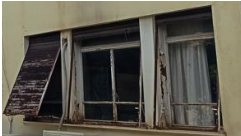
Εικόνα 7: Μορφή των υαλοστασίων του κτιρίου “Α” με τα εξωτερικά στόρια
