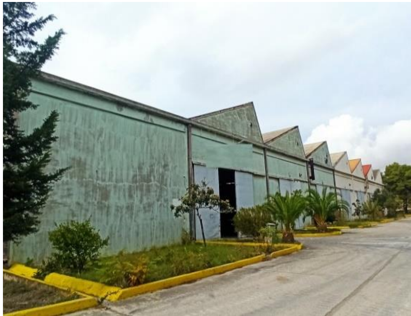
Εικόνα 15: Πρόσοψη του κτιρίου “Ε”
