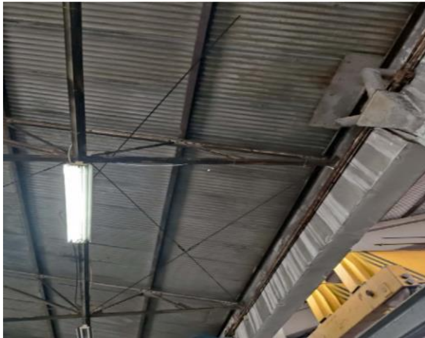
Εικόνα 11: Μορφή και είδος υλικού της οροφής του κτιρίου “Γ”
