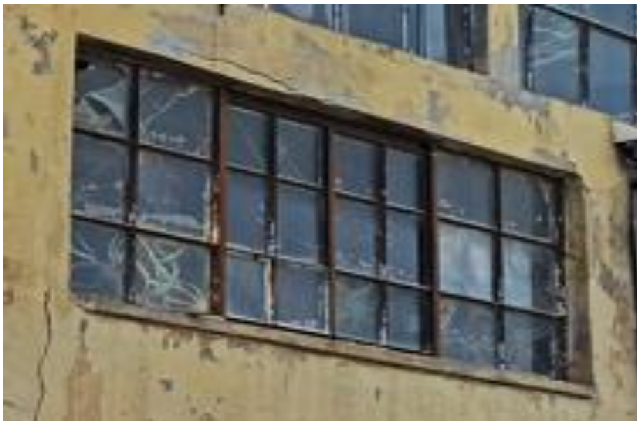
Εικόνα 12: Μορφή των υαλοστασίων του κτιρίου “Γ”
