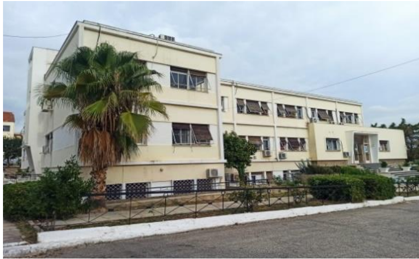
Εικόνα 5: Πρόσωση του κτιρίου “Α”
