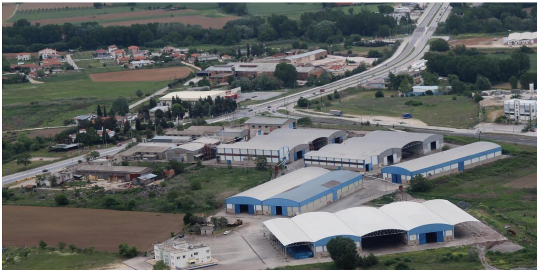
Εικόνα 36. Εγκαταστάσεις της εταιρείας "Θρακικά Εκκοκκιστήρια"
