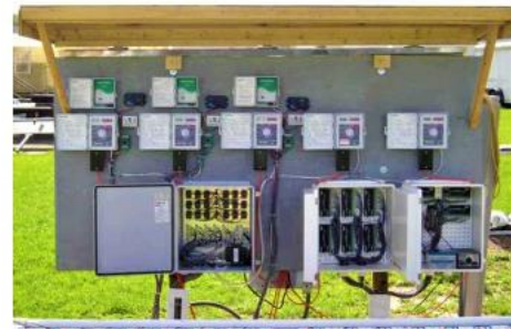
Εικόνα 26. Αισθητήρες διαχείρισης συστημάτων άρδευσης
