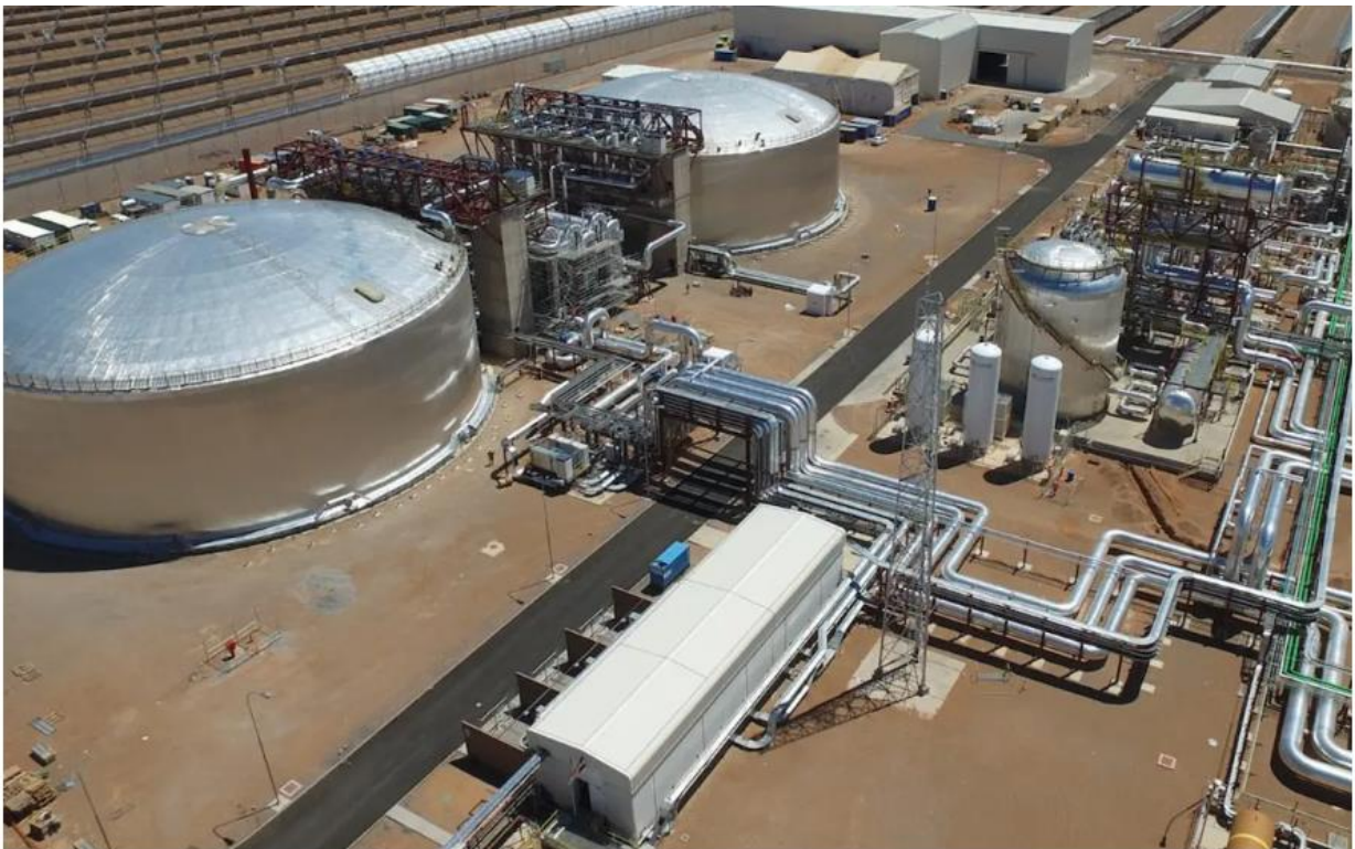
Εικόνα 36: Παράδειγμα εγκατάστασης τηγμένου άλατος (Πηγή: Aurora Li, 2023)
