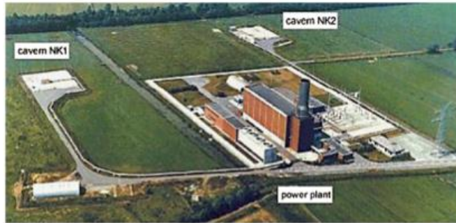
Εικόνα 16: Παράδειγμα CAES στο Huntorf της Γερμανίας με δυναμικότητα 290 MW (Πηγή: Mahlia et al, 2014)
