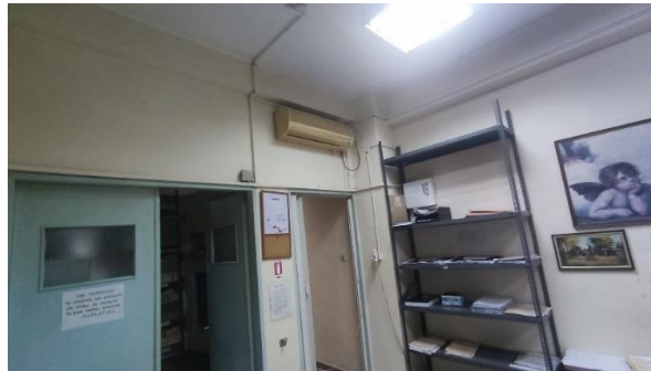
Σχήματα 6.16: Παλιό κλιματιστικό split του νοσοκομείου
