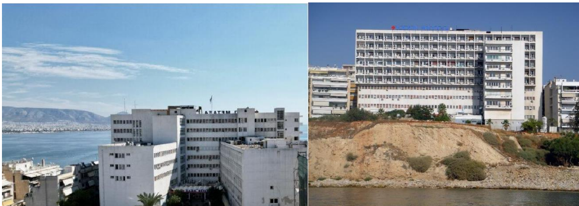
Σχήματα 9.12 & 9.13: Ανατολική και δυτική όψη του νοσοκομείου «Μεταξά» [75]
