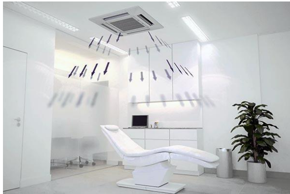
Σχήμα 6.10: Μονάδα τύπου «κασέτας» [16]
