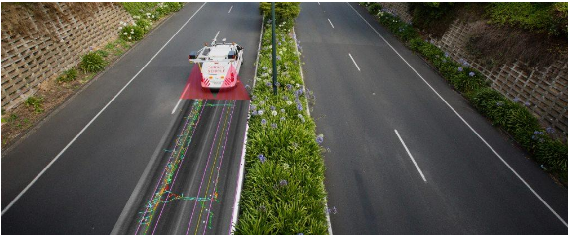
Σχήμα 22: Ανίχνευση ρωγμών στους αυτοκινητόδρομους με χρήση της τελευταίας τεχνολογίας σκαναρίσματος με laser [79]
