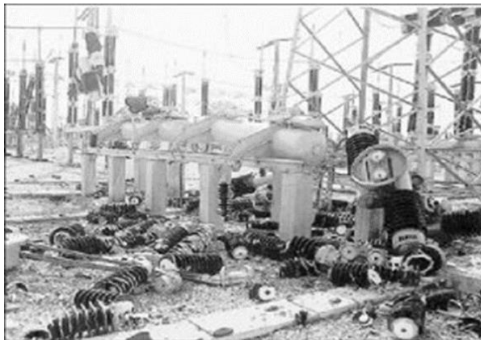
Εικόνα 1.6: Το ΚΥΤ Αχαρνών μετά το μεγάλο σεισμό του Σεπτεμβρίου, 1999 [15].
