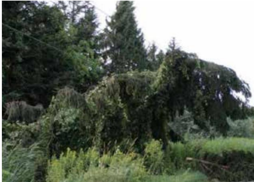
Εικόνα 1.5: Καταστροφή εναέριου Δικτύου εξαιτίας ισχυρών ανέμων [6].
