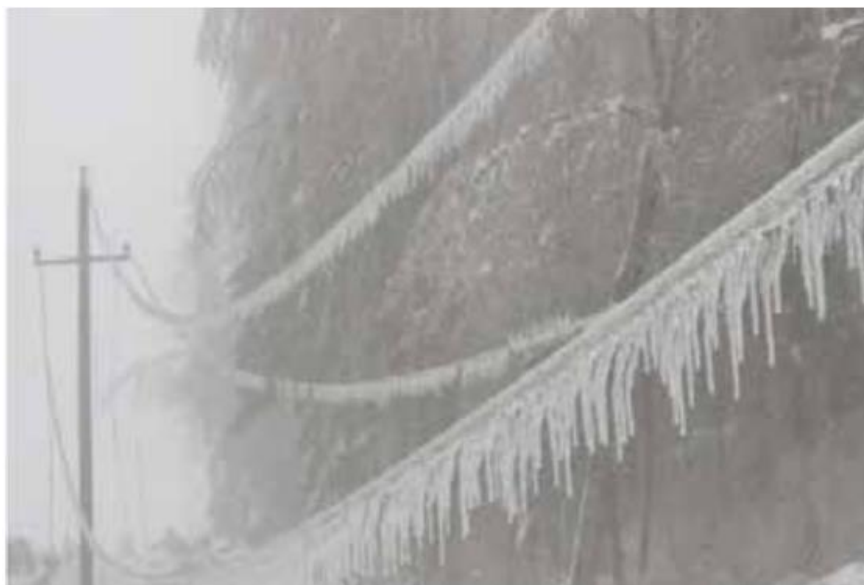
Εικόνα 1.4: Πάγος σε αγωγούς Δικτύου [6].
