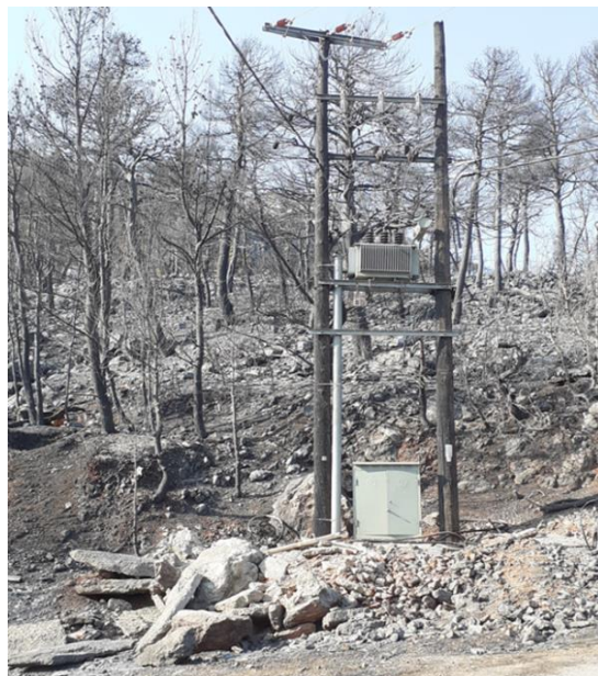
Εικόνα 1.10: Καταστροφή εναέριου Υ/Σ από πυρκαγιά, Ιπποκράτειος Πολιτεία 2021.
