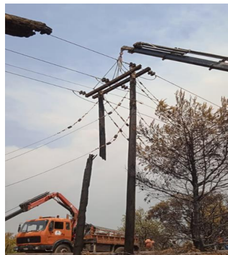
Εικόνα 1.15: Αποκατάσταση εναερίου Δικτύου.
