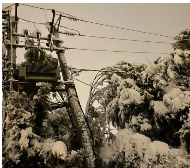
Εικόνα 1.16: Υποχώρηση δίστυλου Μ/Σ από το βάρος του χιονιού.
