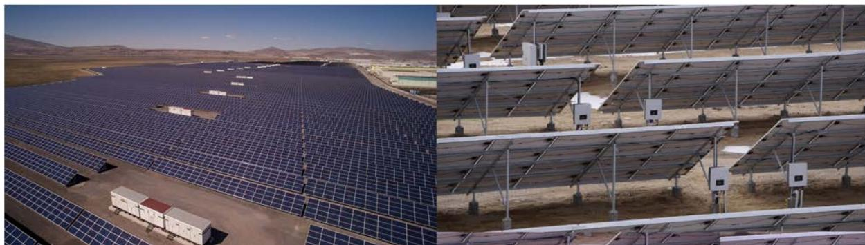
*Εικόνα 17 Φωτοβολταϊκός Σταθμός με Κεντρικούς Αντιστροφείς (Αριστερά) και Αντιστροφείς Σειράς (Δεξιά) (Lusson, 2024)*
