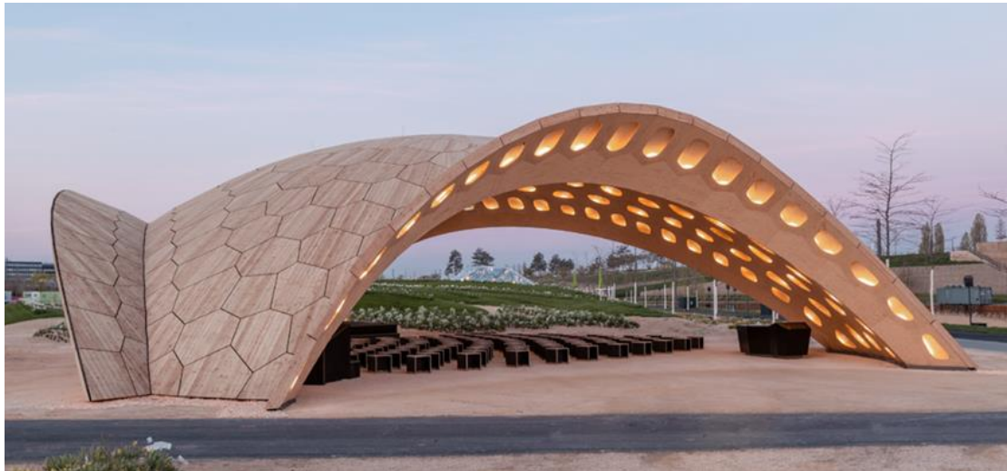
Εικόνα 5: BUGA Wood Pavilion. Παράδειγμα έργου NEB που αναπτύχθηκε από μια διεπιστημονική ομάδα αρχιτεκτόνων, μηχανικών, τεχνιτών και δημόσιων φορέων και από το Πανεπιστήμιο της Στουτγκάρδης, το 2019, στην Γερμανία. Λόγω του καινοτόμου της σχεδίασής του, μπορεί να επανασυναρμολογηθεί πλήρως αν μεταφερθεί σε νέα τοποθεσία, αλλά και να ανακυκλωθεί πλήρως σε περίπτωση μη αξιοποίησής του πια. Πηγή: Ευρωπαϊκή Ένωση
