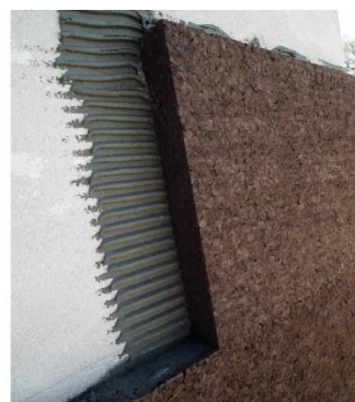
Σχήμα 2.15: Επεξεργασμένες πλάκες φελλού (αριστερά) και τοποθέτηση τους (δεξιά).
