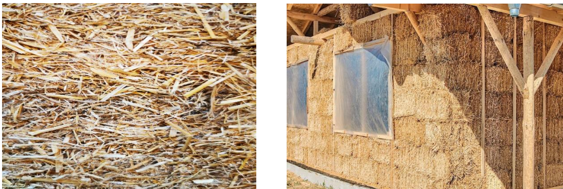
Σχήμα 2.12: Άχυρο ρυζιού (αριστερά) ως εξωτερική θερμομόνωση (δεξιά).
