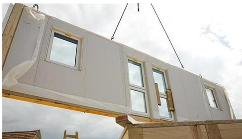
Σχήμα 2.1: Μεταφορά προκατασκευασμένου στοιχείου πρόσοψης εντός εργοταξίου.
