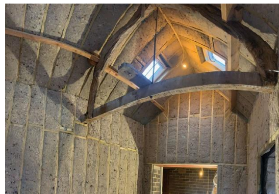
Σχήμα 2.13: Μαλλί προβάτου (αριστερά) ως θερμομόνωση κτιρίου (δεξιά).
