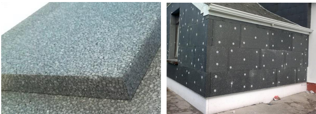
Σχήμα 2.4: Διογκωμένη πολυστερίνη (αριστερά) και η εφαρμογή της σε κτίριο (δεξιά).
