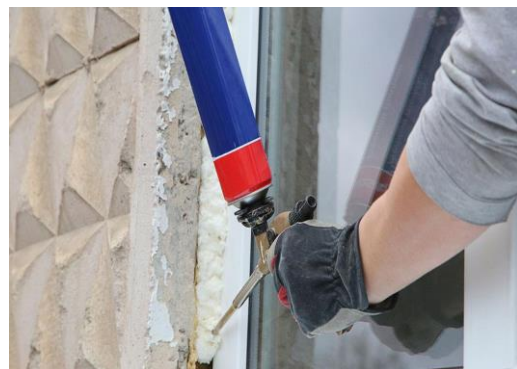
Σχήμα 2.5: Πάνελ πολυουρεθάνης (αριστερά) και εφαρμογή αφρού πολυουρεθάνης (δεξιά).
