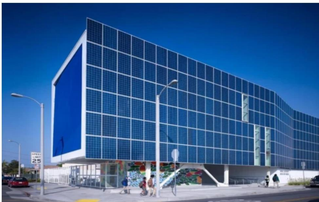
Εικόνα 4: Φ/Β πάνελ σε πρόσοψη σχολείου προσφέρουν ενέργεια και σκιά [26]
