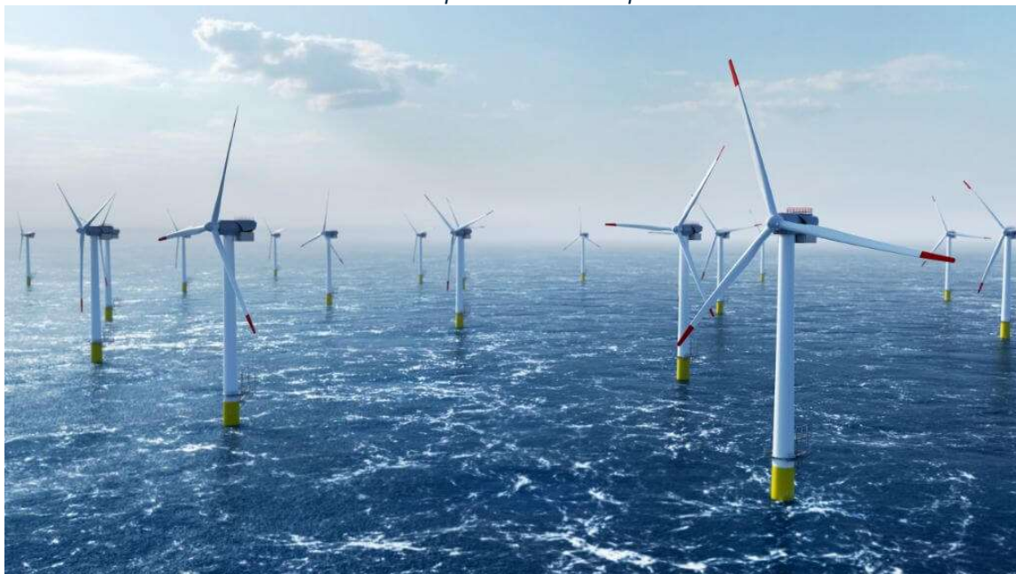
Εικόνα 4.Υπεράκτιο Αιολικό Πάρκο
