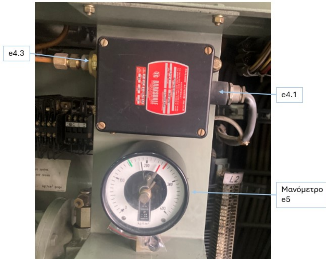
Εικόνα 5.14 Μανόμετρο και πρεσοστάτες
