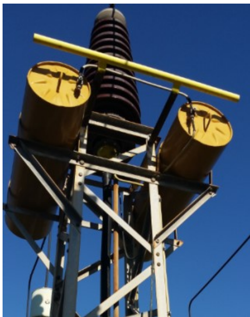
Εικόνα 3.5 Δοχεία διαστολής στο ένα άκρο του καλωδίου
