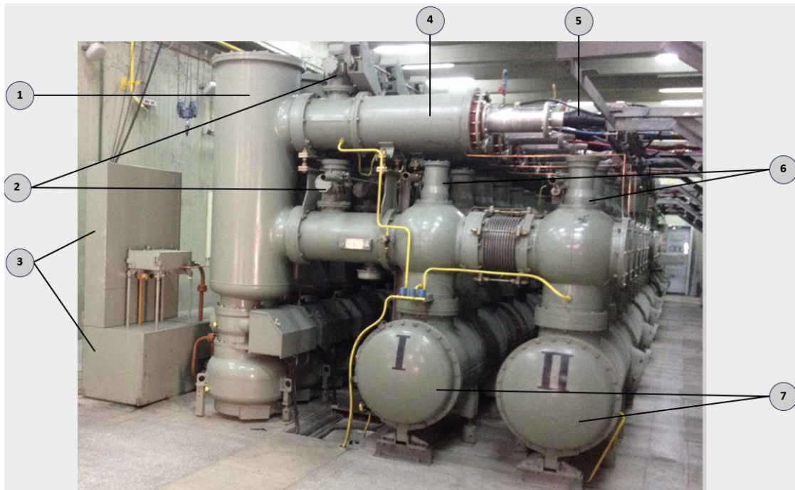
Εικόνα 3.1 GIS 150kV
