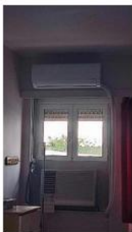
Σχήματα 6.17: Κλιματιστικό split inverter καινούργιο μαζί με κλιματιστικό παραθύρου που δεν λειτουργεί [36]
