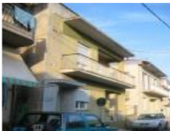
Εικόνα 4: Κτίριο στη Ζώνη Γ
