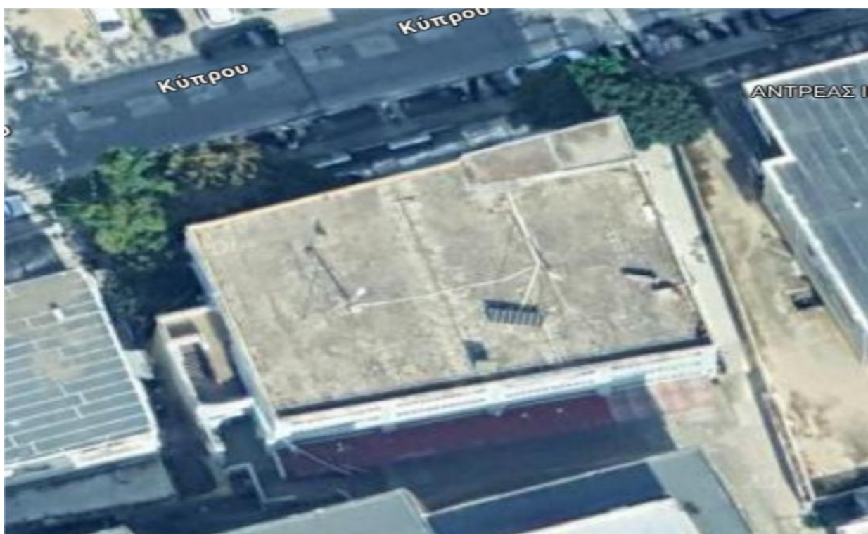
Σχήμα 3.6. Πανοραμική άποψη της εξεταζόμενης κτιριακής εγκατάστασης [6].
