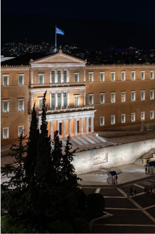
Εικόνα 27: Φωτισμός όψης της Βουλής και του μνημείου Αγνώστου Στρατιώτη.[27]
