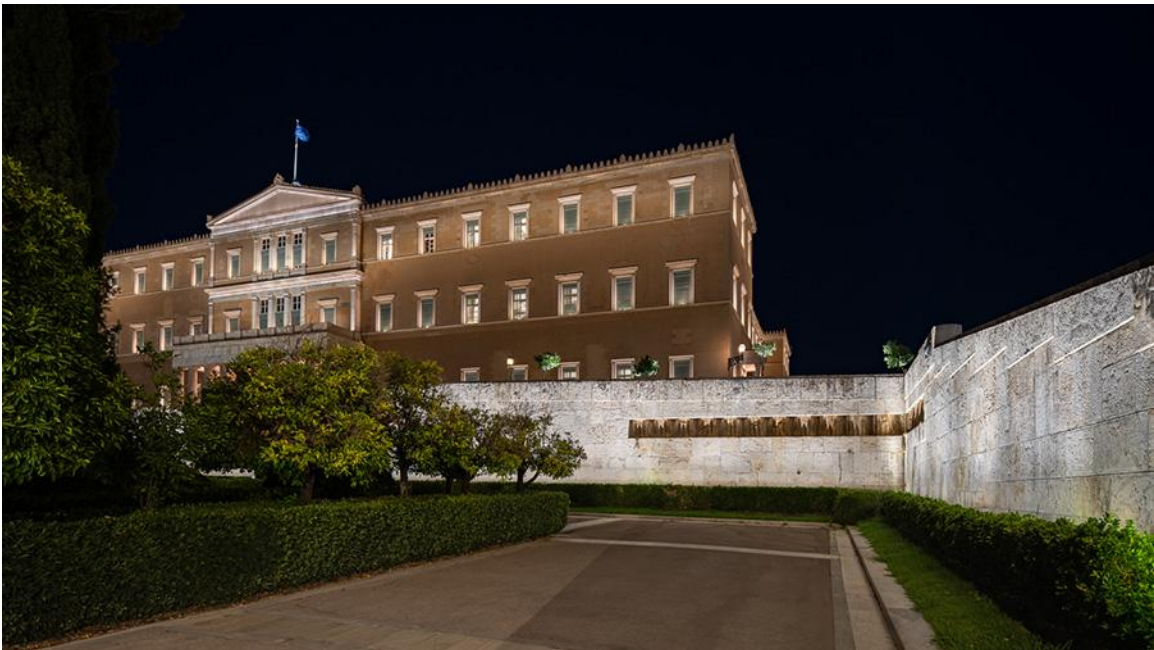
Εικόνα 28: Φωτισμός περιμετρικού πέτρινου τοίχου.[27]
