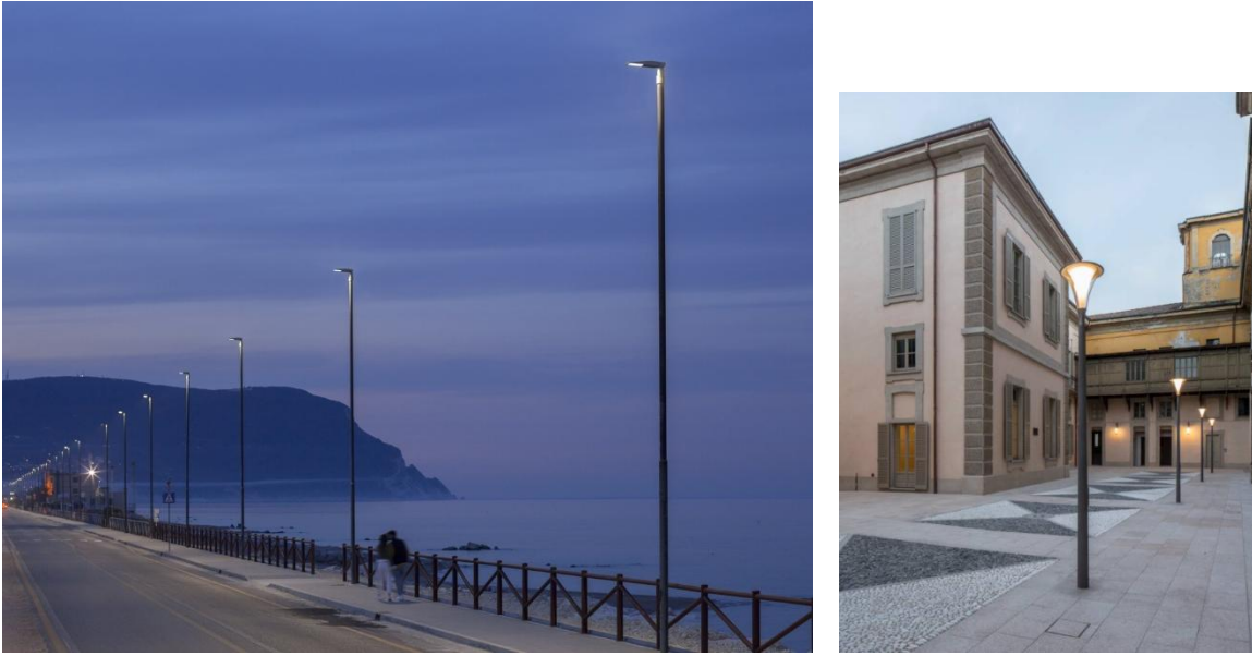
Εικόνα 24: Αριστερά φωτιστικό οδοφωτισμού σε ψηλό ιστό, δεξιά φωτιστικό πλατείας σε χαμηλό ιστό. [49]
