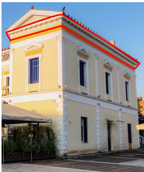
Εικόνα 63: Με κόκκινο σημειώνονται τα σημεία τοποθέτησης των φωτιστικών E07.
