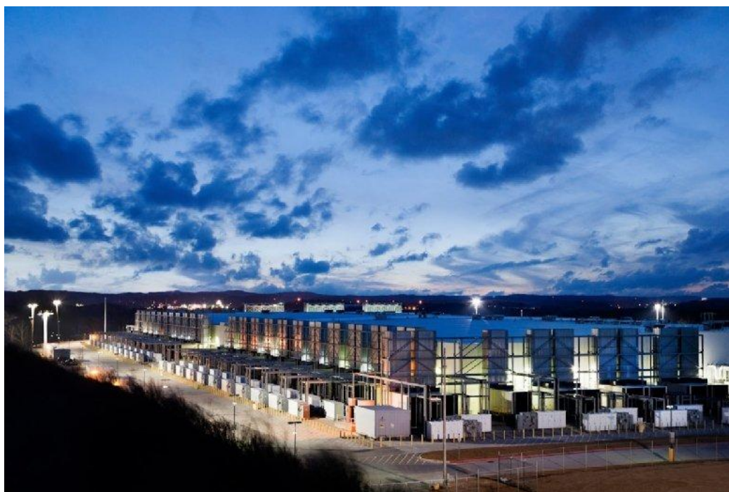
Εικόνα 1-1: Κέντρο δεδομένων της Google στην Georgia, ΗΠΑ.
