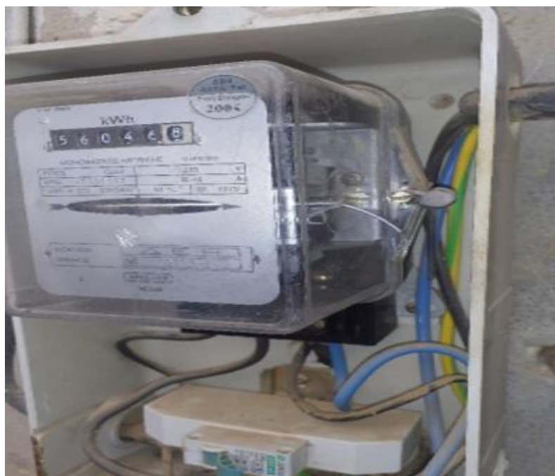
Εικόνα 3.18 Τοποθέτηση σύρματος (μέσω αυτοσχέδιας οπής) στο ύψος του δίσκου του μετρητή [34]
