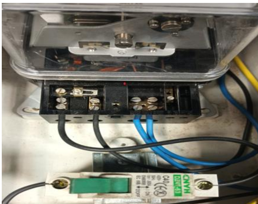
Εικόνα 3.10 Ανοιχτός γεφυροσύνδεσμος μονοφασικού μετρητή [34]
