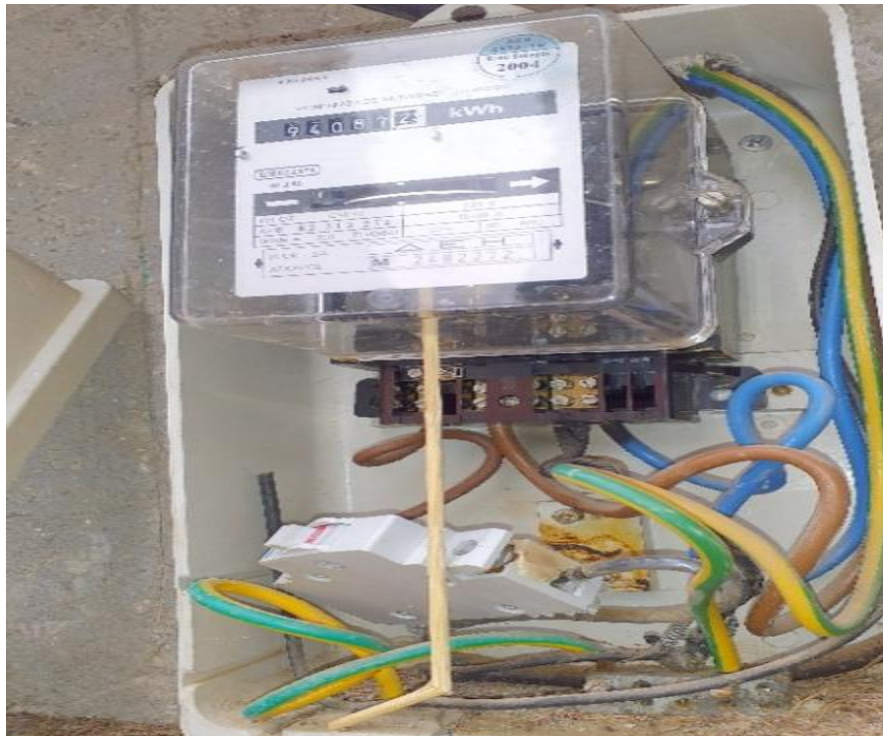
Εικόνα 3.20 Τοποθέτηση ξύλινης ράβδου κάτω από τον δίσκο του μετρητή [34]
