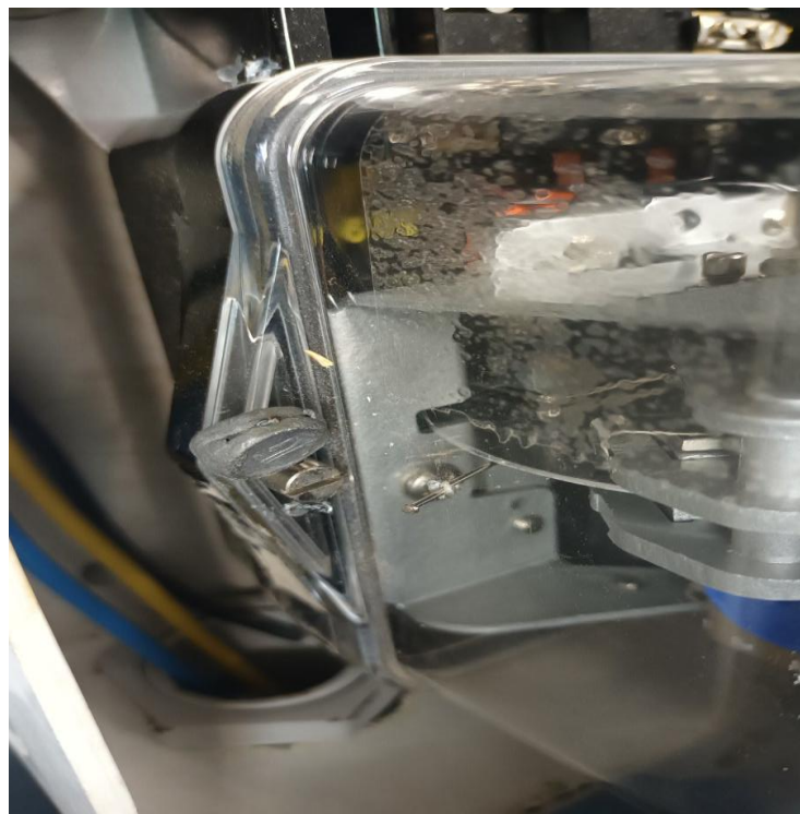
Εικόνα 3.17 Τοποθέτηση καρφίου (μέσω αυτοσχέδιας οπής) στο ύψος του δίσκου του μετρητή [34]
