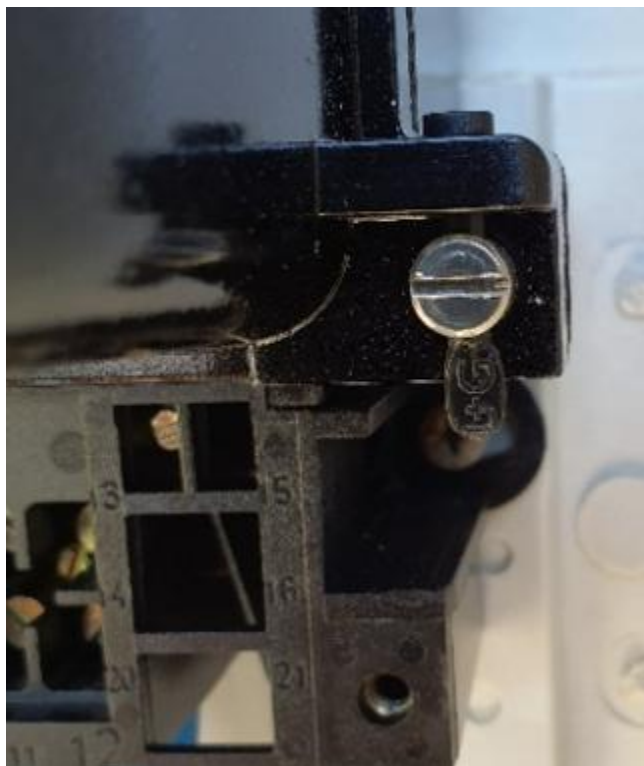
Εικόνα 3.25 Πλαστές σφραγίδες καλύμματος μετρητή [34]
