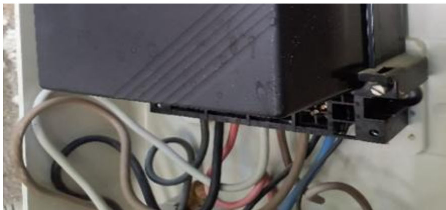
Εικόνα 3.24 Κομμένες σφραγίδες καλύμματος μετρητή [34]
