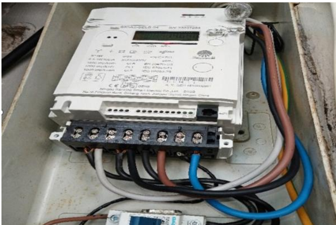
Εικόνα 3.9 Δημιουργία γεφυρών στους ακροδέκτες σύνδεσης του μετρητή [34]
